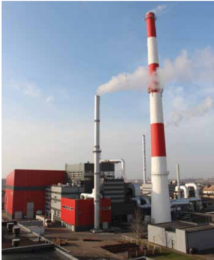
Šiaulių termofikacinė elektrinė
