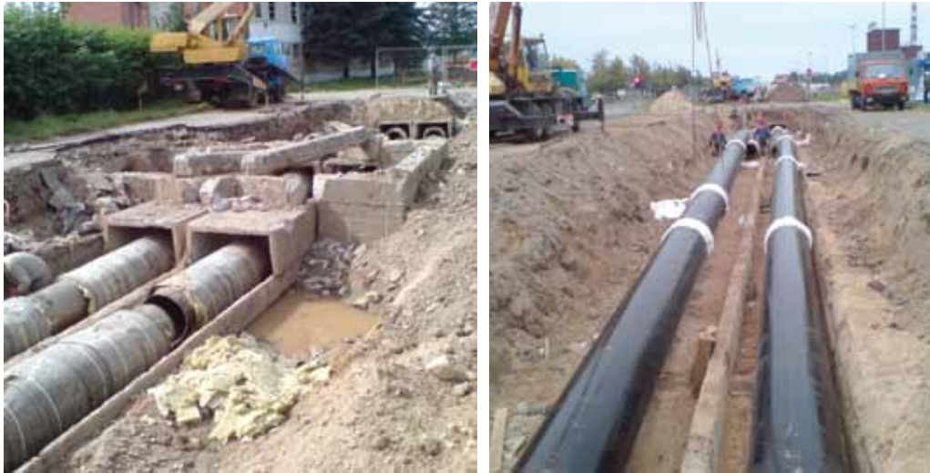
Seni susidėvėję šilumos tinklai visose šilumos tiekimo įmonėse keičiami naujais
