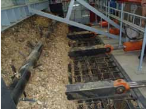
Biokuro padavimo iš sandėlio į katilinę transporteris (UAB „Pakruojo šiluma“ rekonstruotoje 5 MW šiluminės galios rajoninėje katilinėje, 2014 m. liepa)
