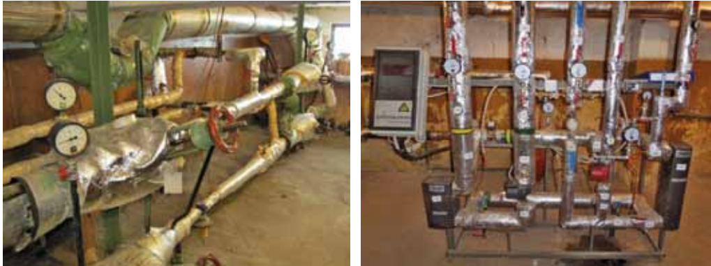
Daugiabučiuose gyvenamuosiuose namuose seni elevatoriniai šilumos punktai keičiami į automatizuotus. Šilumos tiekimo įmonės investavo apie 350 mln. Lt
