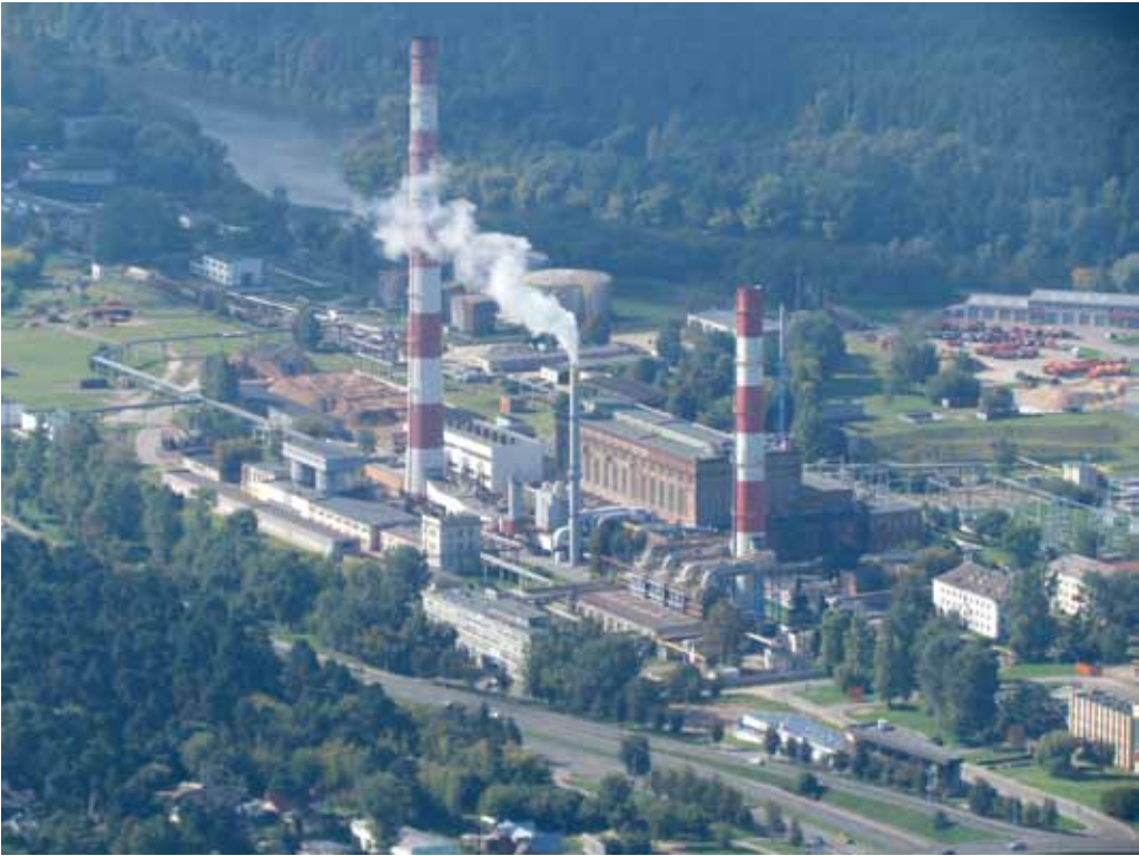
Vilniaus elektrinės Savanorių pr. (TE-2) bendras vaizdas
