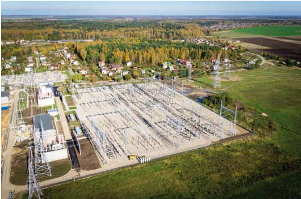
Klaipėdos transformatorių pastotė
