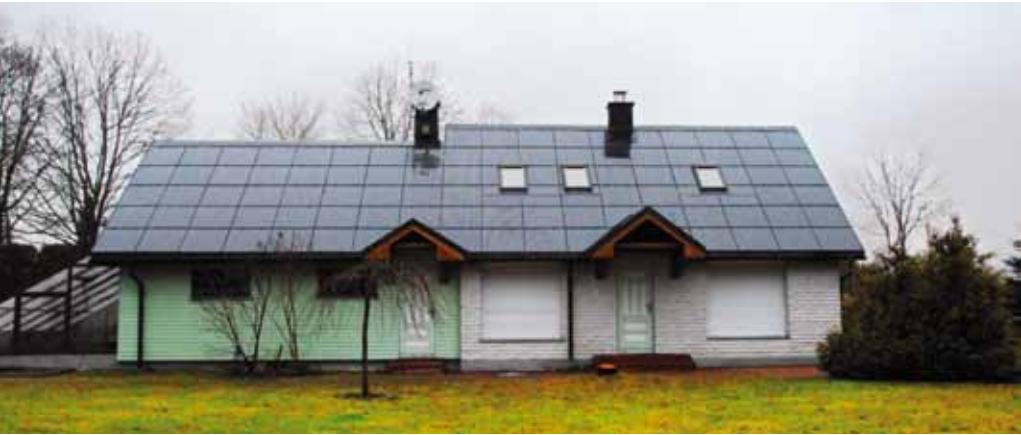
11 kW saulės jėgainė Molėtų r., sumontuota ant pastato integruotu būdu
