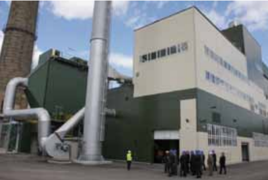
UAB „Litesko“ Alytaus biomasės kogeneracinės elektrinės korpusas su elektrostatiu dūmų filtru (2012 m. gegužės 18 d.)
