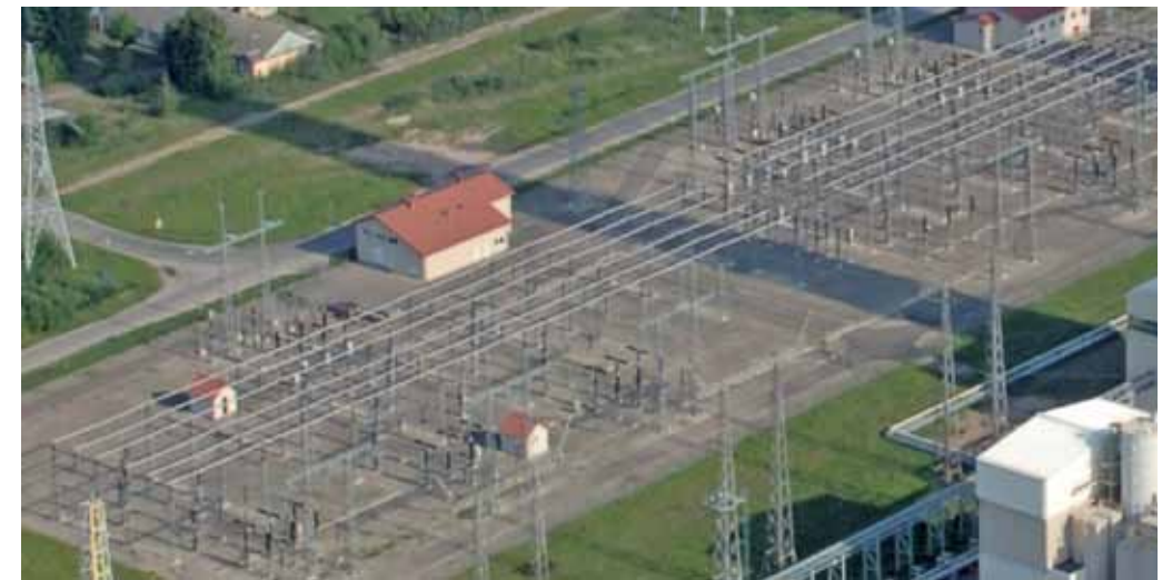
Skirstykla po rekonstrukcijos
