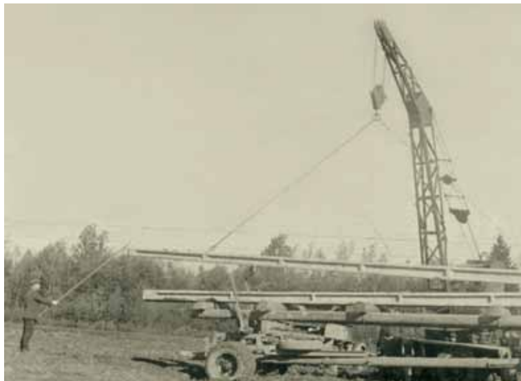
Alytaus elektros tinklai. Mechanizuotas atramų pakrovimas, 1965 m.
