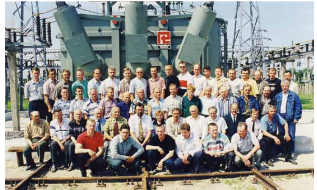
Kauno elektros tinklų Pastočių tarnybos darbuotojai prie pirmo respublikoje sumontuoto „Pawels“ kompanijos gamybos 330 kV 125 MVA autotransformatoriaus, 2000 m.
