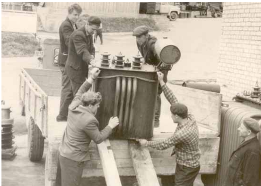
Transformatorių pakrovimas, kol įmonė neturėjo automobilinio kranų
