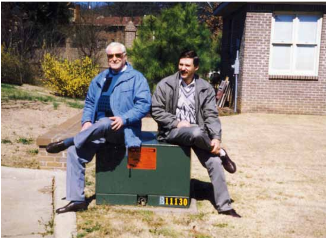
B. Paškevičius (kairėje) ir J. Dumbrava ant 35 kV transformatorinės pastotės Alabamoje, JAV
