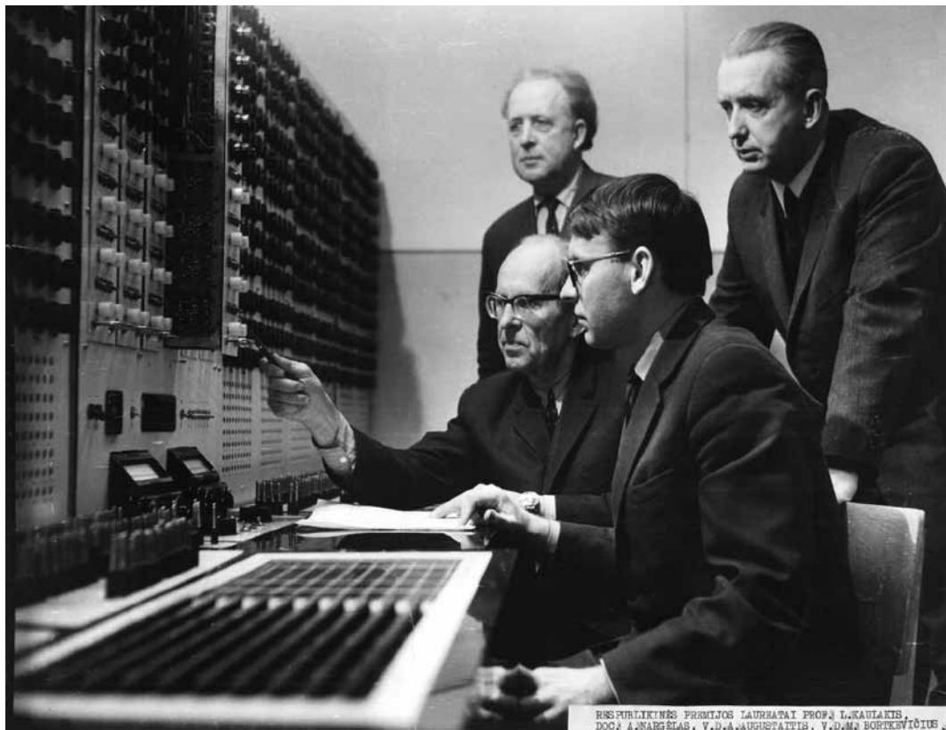
Nuolatinės srovės elektros sistemų analizatorius ir jo kūrėjai (L. Kaulakis, M. Bartkevičius, A. Nargėlas, A. Augustaitis, 1967 m.)
