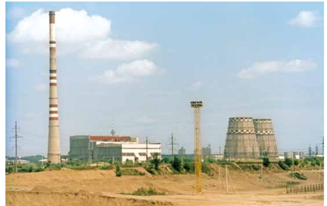
Baigiama elektrinės statyba, 1986 m.
