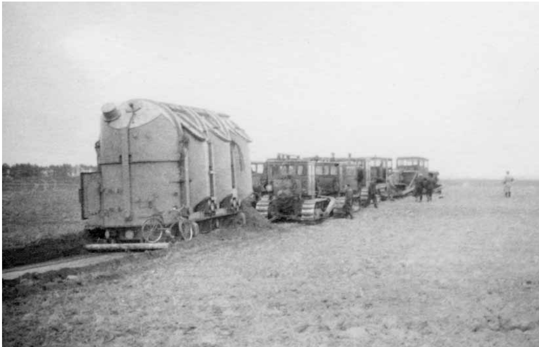
330 kV autotransformatoriaus „kelionė“ į Vilniaus pastotės statybos aikštelę, 1964 m.
