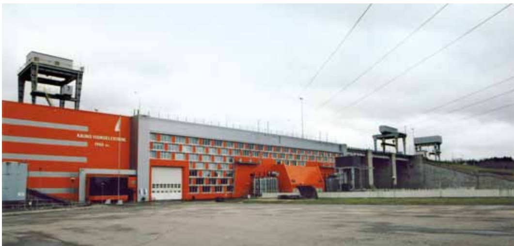
Kauno HE fasadas po rekonstrukcijos
