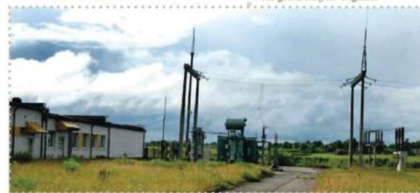
Elektros linijas ir transformatorines pastotes montuoja šešias UAB „Anykščių energetinė statyba“ brigados.
