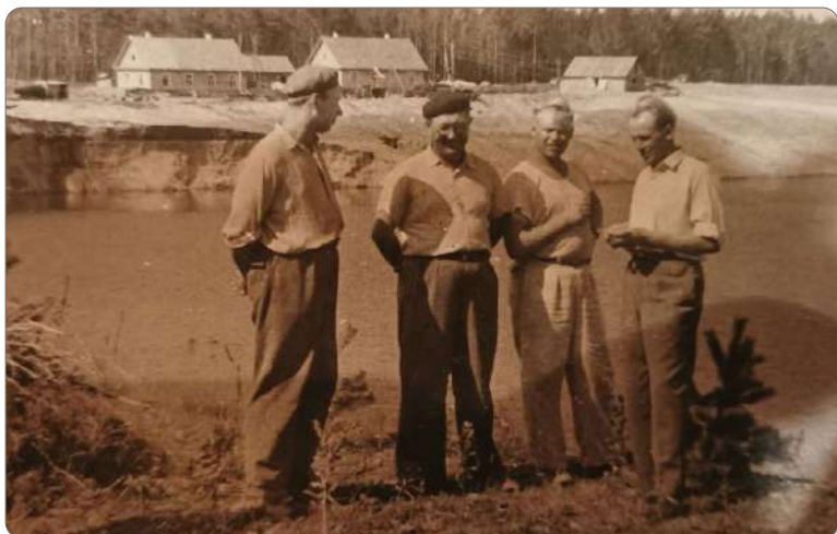
Baltosios Ančios hidroelektrinės statybos vietoje 1954 m. Antras iš kairės – Teodoras Bitinas
