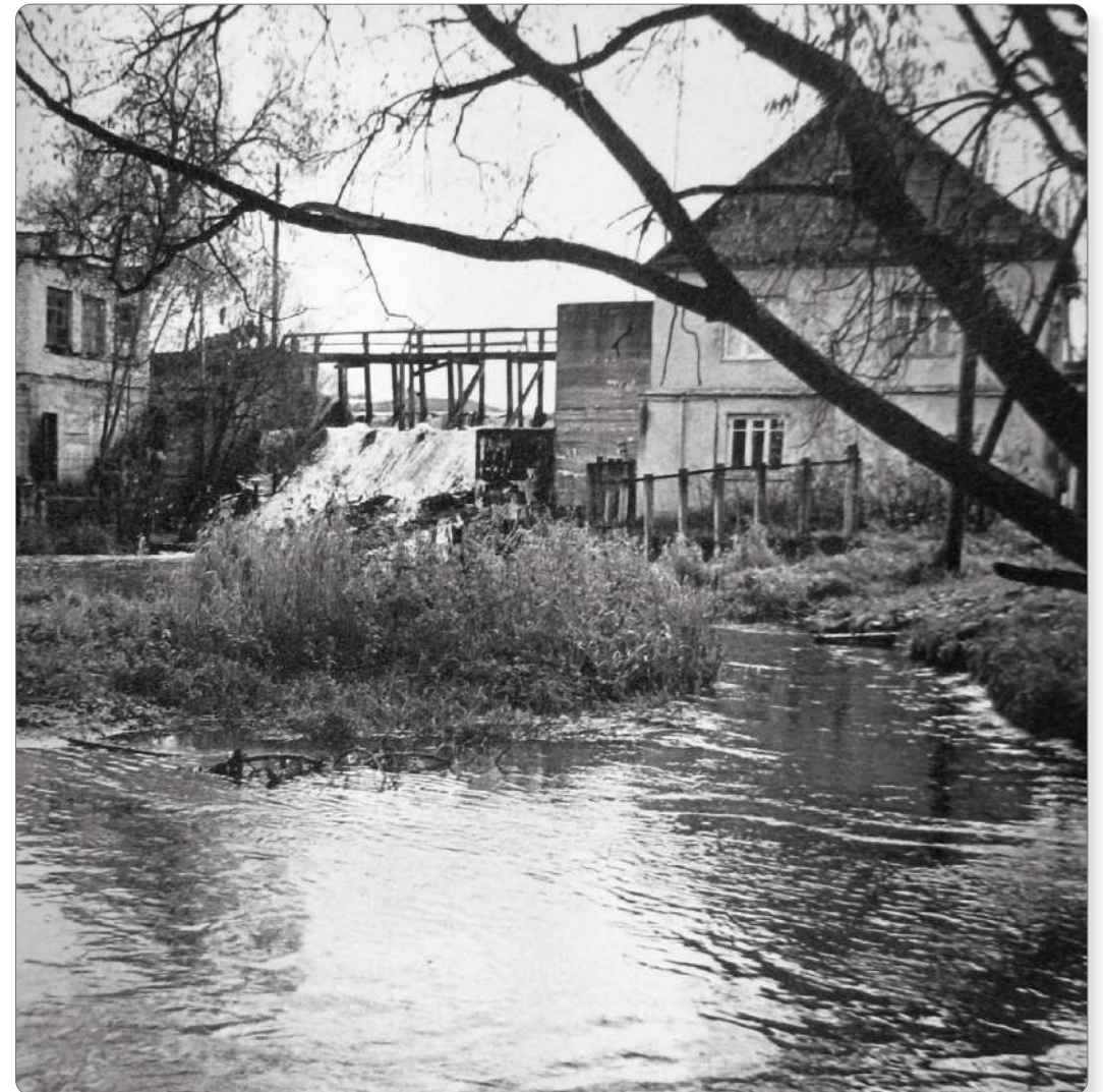
Anykštos upelio hidroelektrinė ir namas, kuriame 1947 m. gyveno Alvydas su šeima
