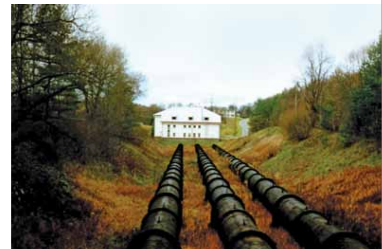
Gelžbetoniniai slėginiai vamzdžiai
