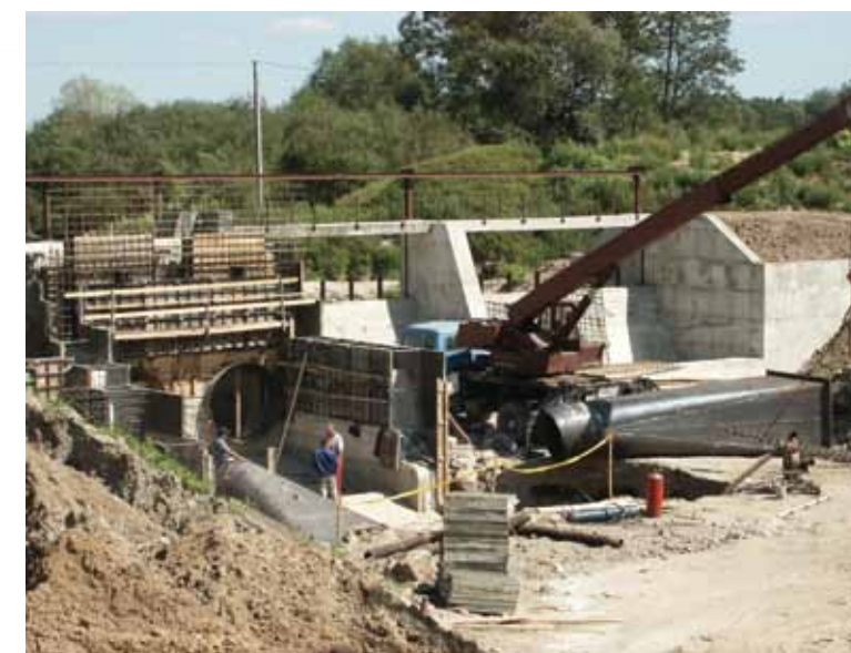
Hidroelektrinės atstatymo darbai
