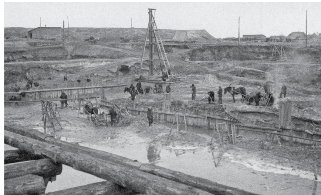
9 pav. Turniškių hidroelektrinės statyba, 1939 m. lapkritis. Stepono Kolupailos nuotrauka
