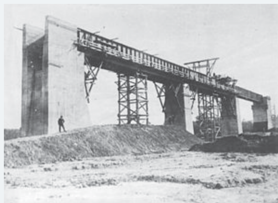
Kūlupėnų geležinkelio tilto statyba per Salanto upę 1932 m.
