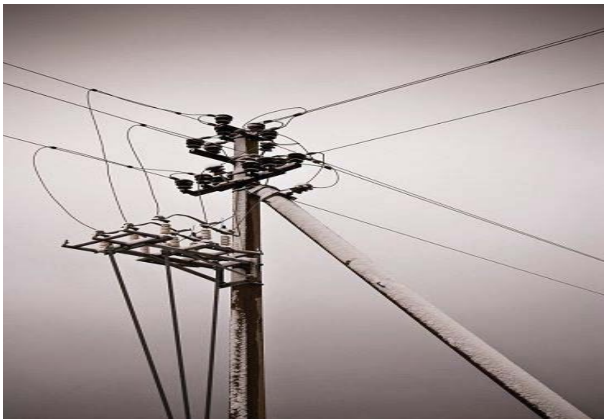
10 kV atsišakojimo stulpas su atrama ir skyrikliais
