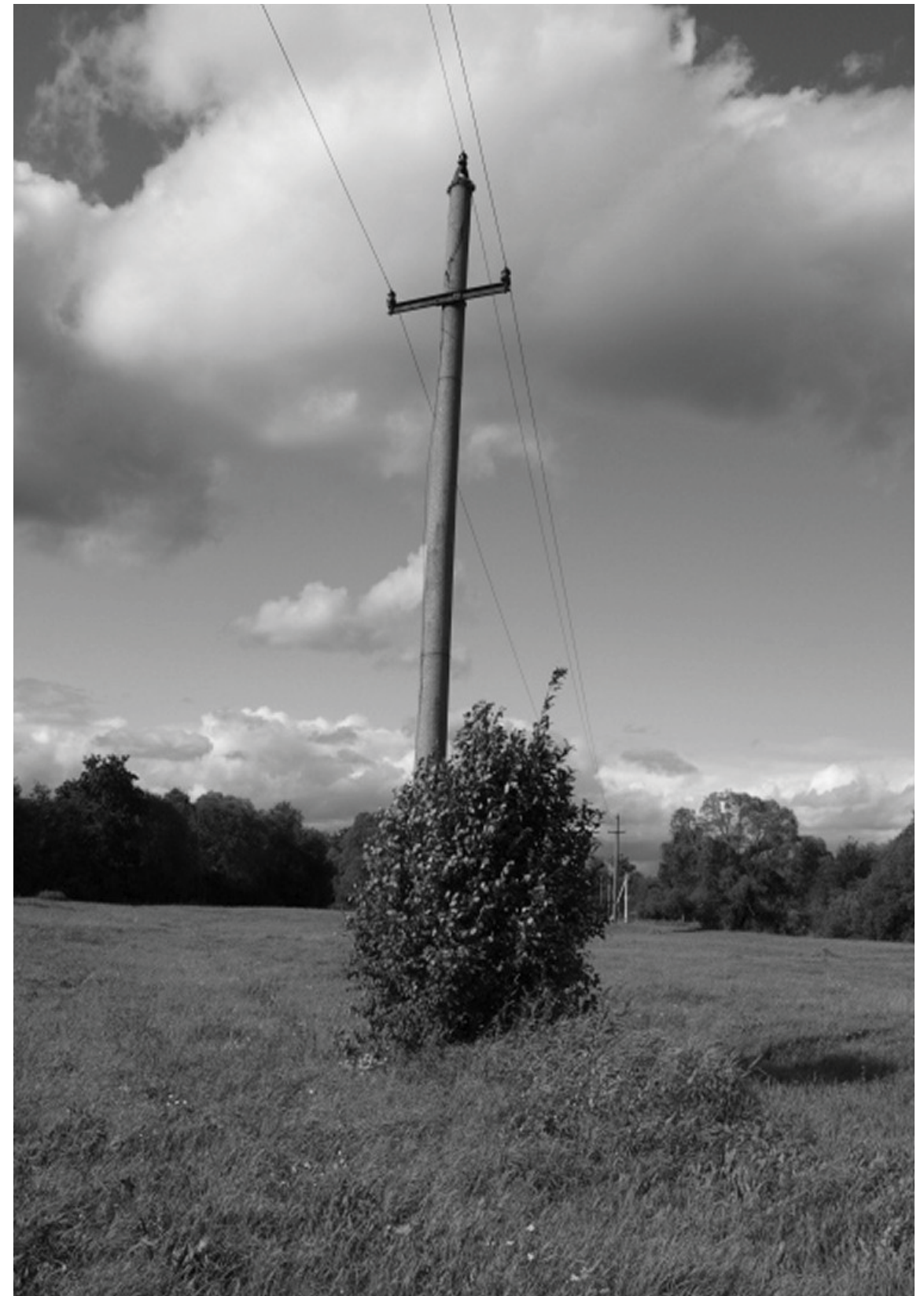
Pirmieji mūsų statyti centrifuguoti konusiniai gelžbetonio stulpai.
