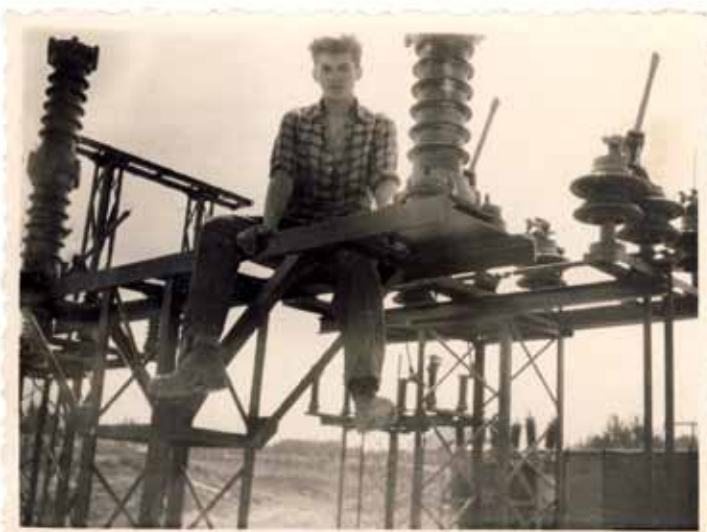
Montuojami įrengimai 35 kV skirstykloje. 1959 m. liepos mėn.
