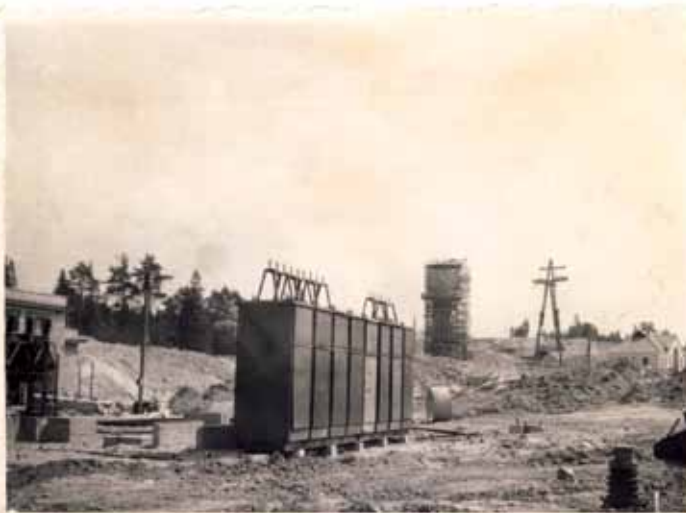
Montuojami 10 kV skirstomieji įrengimai. 1959 m. birželio mėn.
