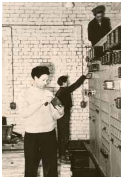
L. Skirpstauskas ir M. Jakučionis (sėdi ant panelio) montuoja Kėdainių 110/35/10 kV valdymo pultą, 1964 m. vasaris–kovas
