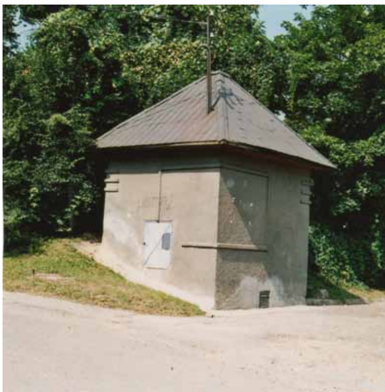
Kėdainių miesto elektros tinklo 6/0,4 kV pastotė Basanavičiaus/Vytauto g., pastatyta 1936–1937 m.
