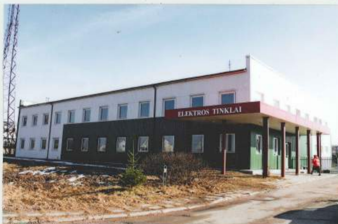
Rekonstruota Raseinių ET skyriaus gamybinė bazė
