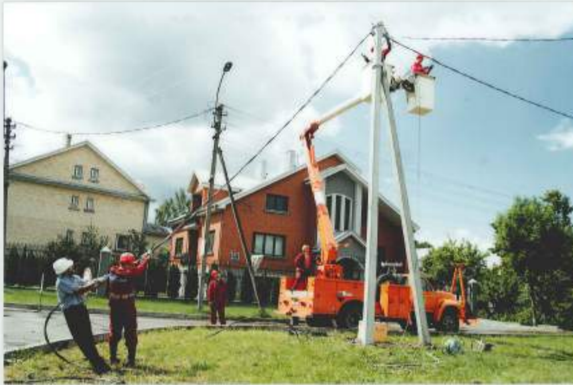
0,4 kV oro linijų rekonstravimas į oro kabelines linijas
