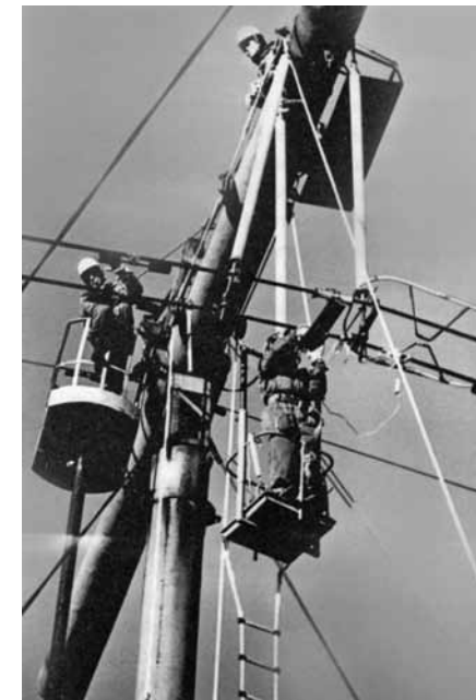
Remonto darbai 330 kV įtampos linijoje neišjungus įtampos
