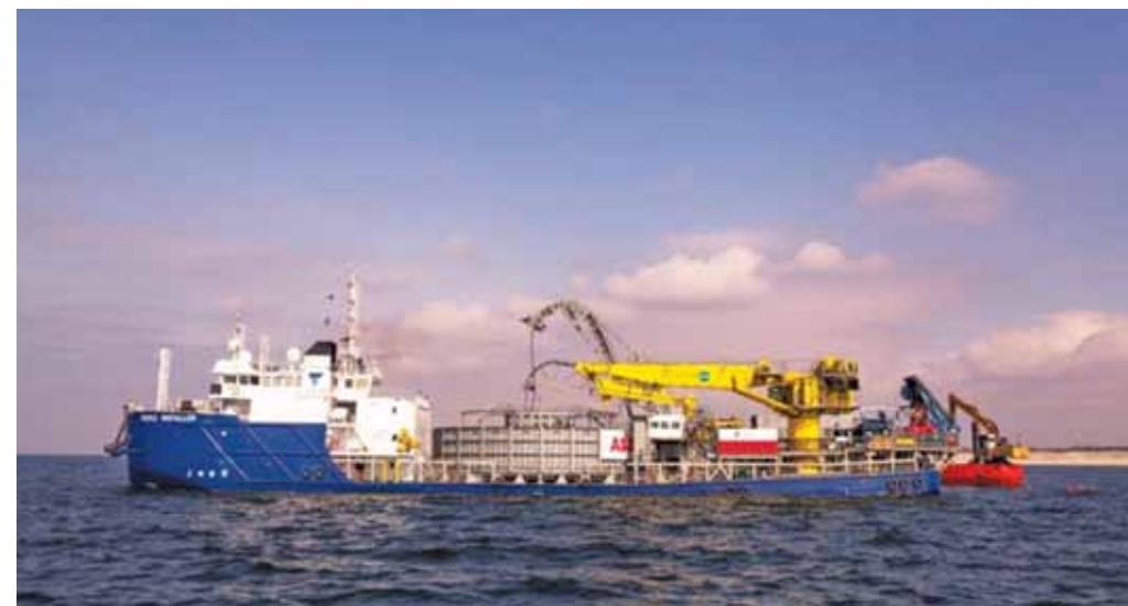
2-11 pav. „NordBalt“ kabelio klojimo darbus vykdamasis galingas laivas „Topaz Installer“
