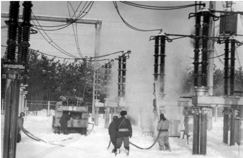
330 kV izoliacijos plovimas Jonavos pastotėje neišjungus įtampos
