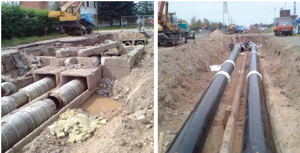
Seni susidėvėję šilumos tinklai visose šilumos tiekimo įmonėse keičiami naujais
