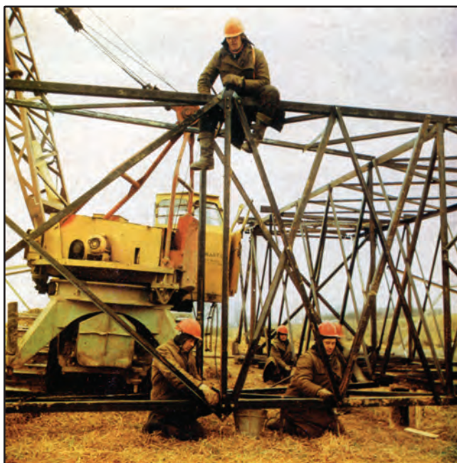
Linijų statytojai surenka 330 kV atramą
