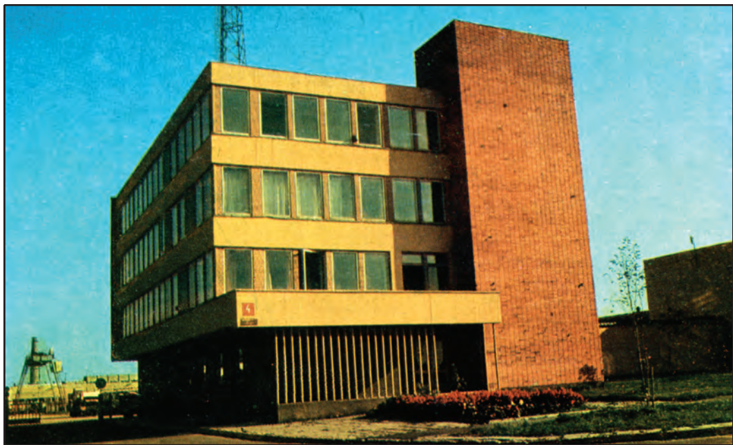
Elektros tiekimo linijų SMV administracinis pastatas Vilniuje, Motorų g. 4
