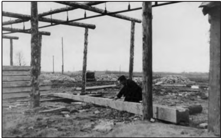
Gelžbetoninių atramų gamybos aikštelė Šakiuose
