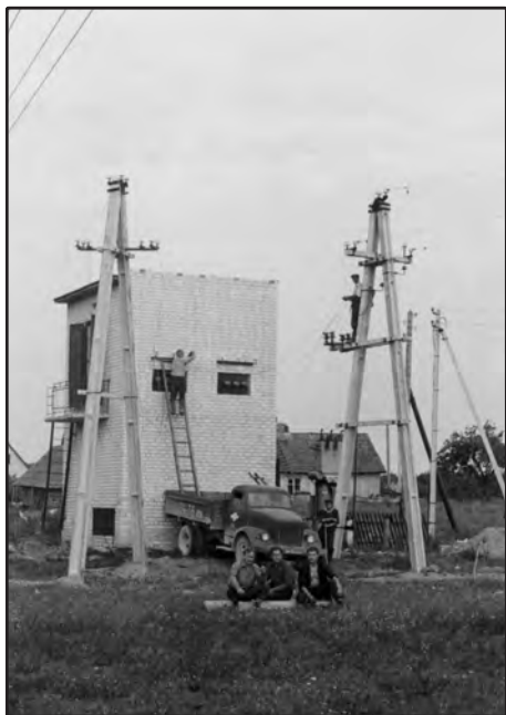
Uždaro tipo transformatoriaus montavimas transformatorinėje pastotėje
