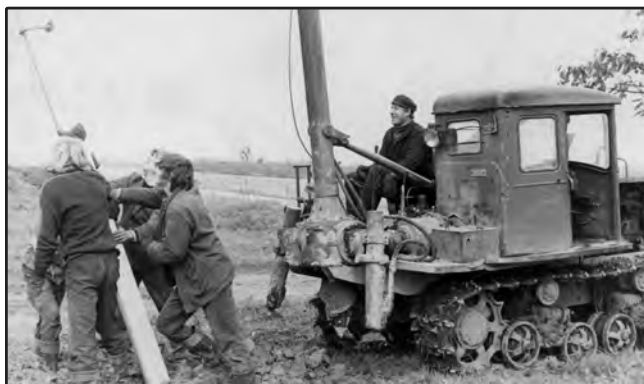
Atramų statymas su gręžimo atramų statymo mašina GBS-58. Mašinistas A. Betingis. 1965 m.
