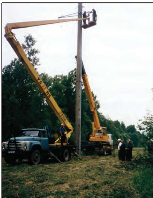
35 kV ET linijos Skuodas–Mosėdis remonto darbai. Keičiama 22 m ilgio atrama
