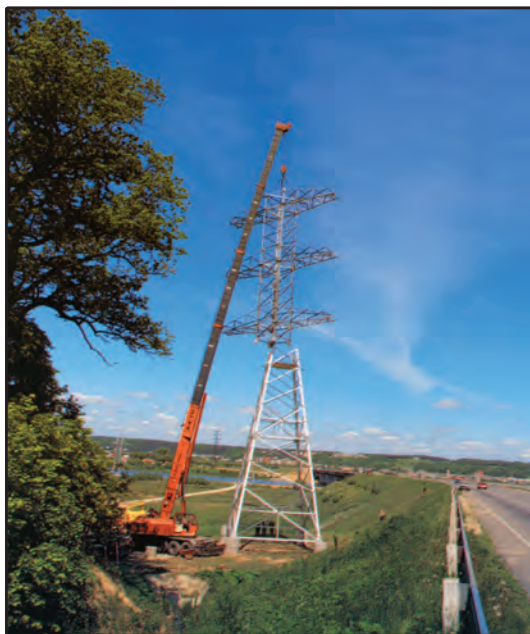
Taip dabar statome 110 kV metalines atramas
