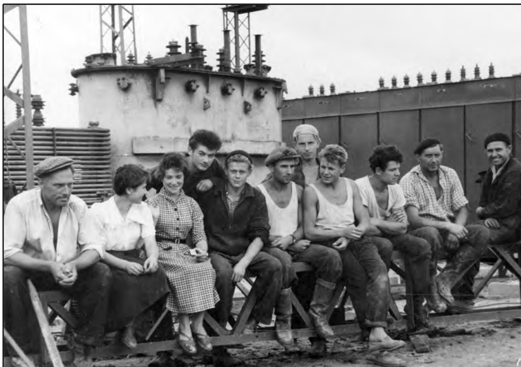
V. Narkevičiaus brigada montuoja Alytaus 110/35/10 kV komplektinę transformatorinę pastotę. Pirmas iš kairės – V. Narkevičius
