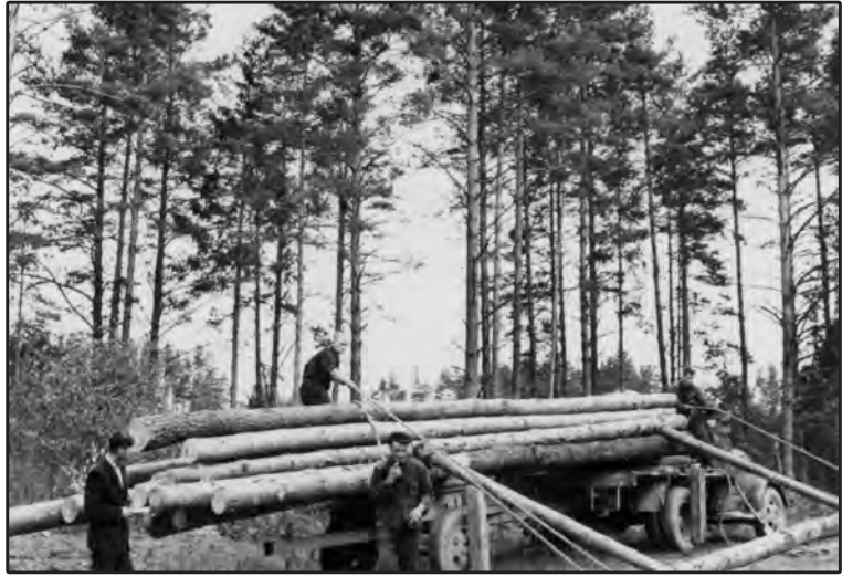
35 kV Ežerėlis–Šakiai ET linijos tiesimo darbai. 1957 m.
