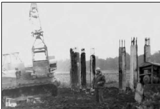
Pamato montavimas 35 kV ETL Šilutė–Rusnė
