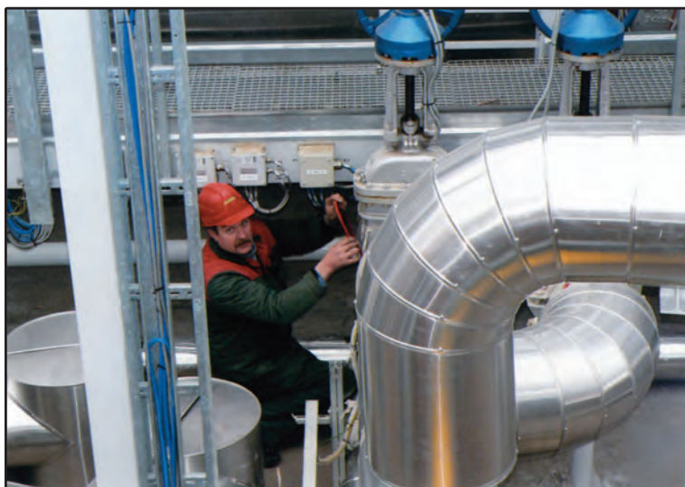
UAB „Krovinių terminalas“ elektrifikavimo darbai. Elektromonteris R. Bendikas
