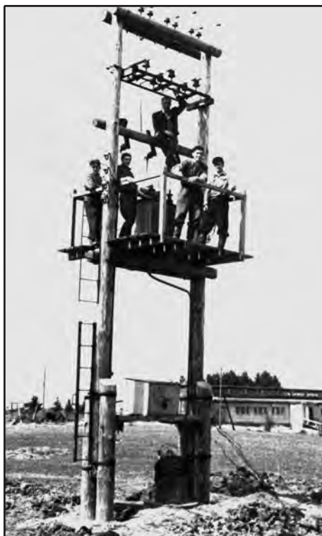
10/0,4 kV įtampos stulpinės transformatorinės pastotės montavimas
