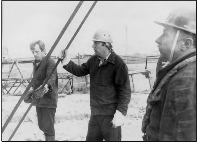
Vyr. mechanikas V. Bargelis (centre) su brigadininku M. Radzevičiumi ir kranininku J. Juškiu montuoja bokštinių kranų
