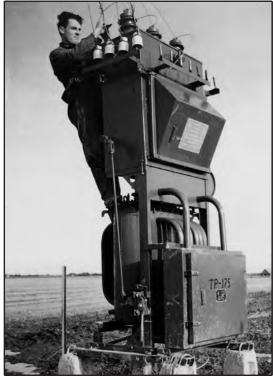
Transformatoriaus montavimas pastotėje
