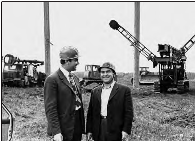
330 kV ETL Klaipėda–Liepoja gelžbetoninė atrama pastatyta
