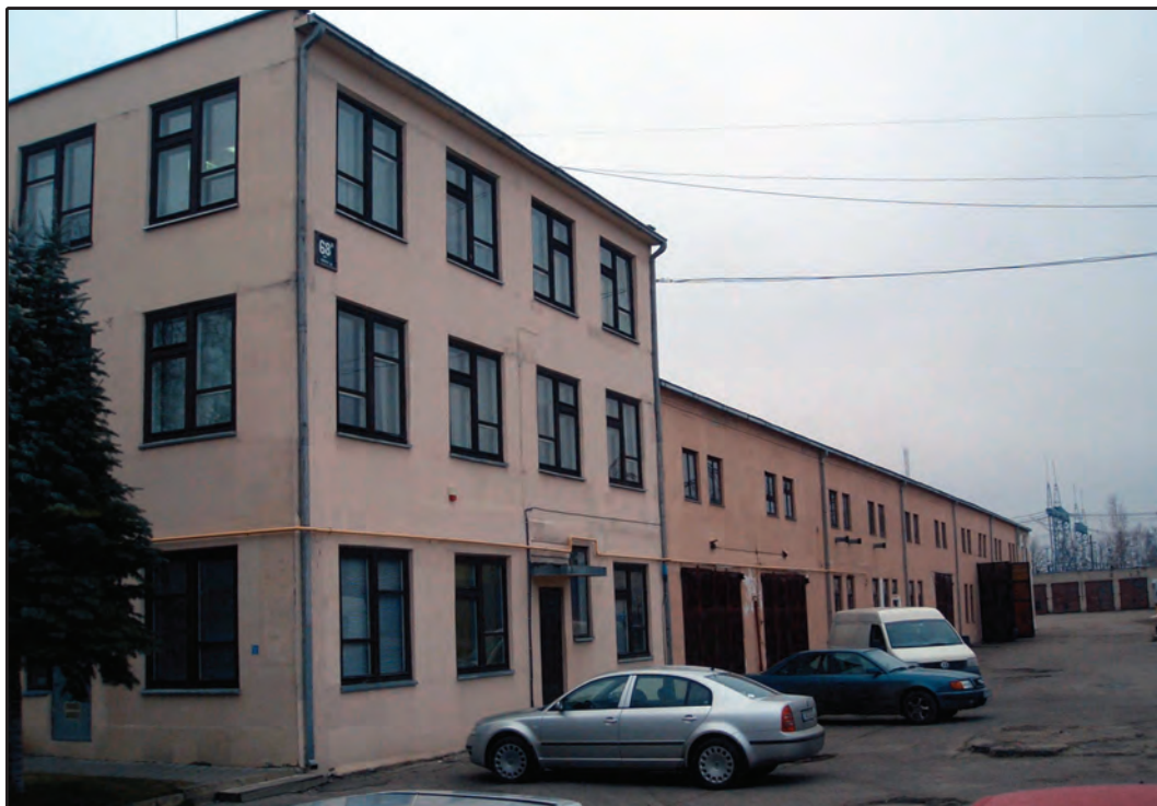
Administracinis pastatas, esantis Šiauliuose, Tilžės g. 68A.
