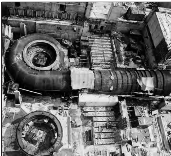
Turbinos spiralinės kameros montavimas
