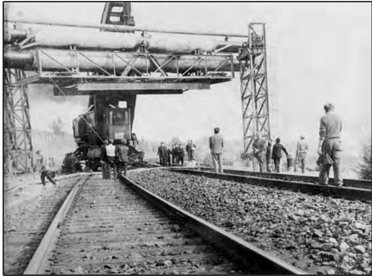
Šiluminės trasos perėjimo per geležinkelį į Dirbtinio pluošto gamyklą montavimas. Dirba E. Eitmanavičiaus brigada
