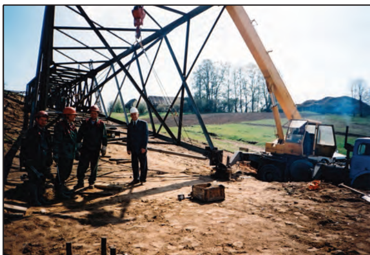
Vyr. darbų vykdytojo R. Kupčinsko brigada stato 35 kV linijos atramą
