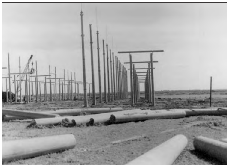
330 kV pastotės montavimas
