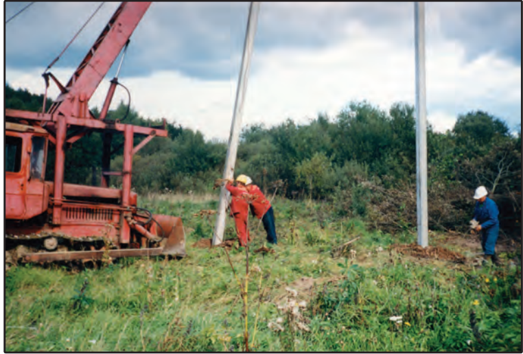
Gelžbetoninių atramų statymo darbai
