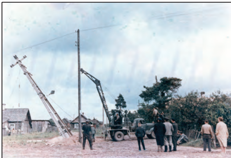
1960 metais Trakų rajone statoma nauja 10 kV inkarinė atrama
