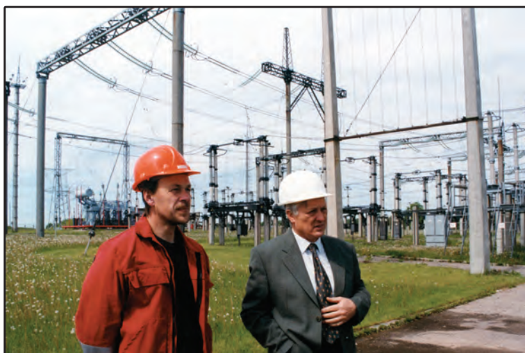
Utenos 330 kV transformatorinė pastotė. 2001 m. gegužė. Generalinis direktorius A. Bitinas (dešinėje) su elektros tinklų dispečeriu
