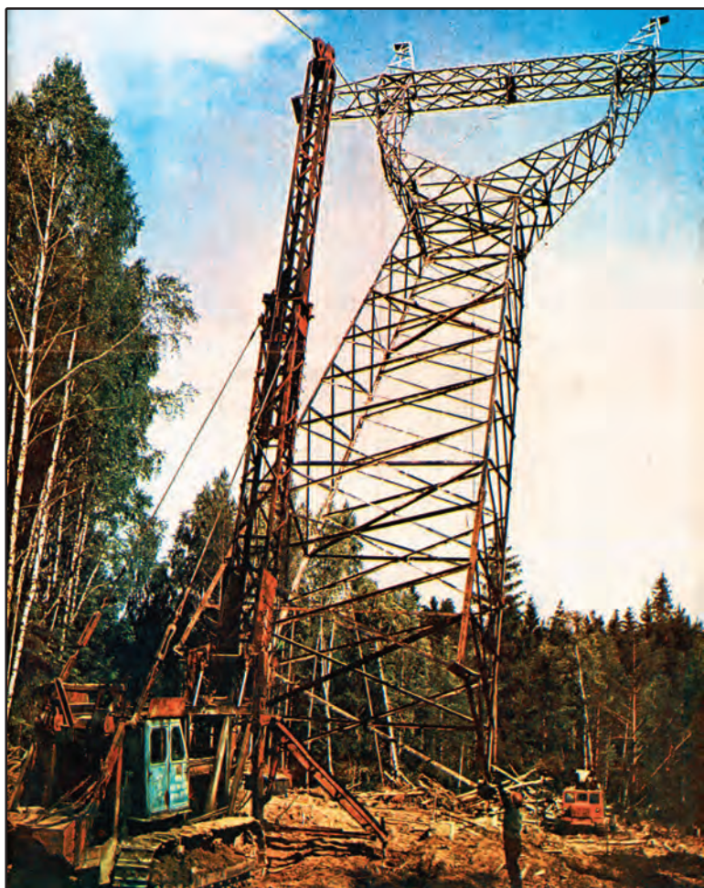
Montuojama Telšių 330 kV TP
