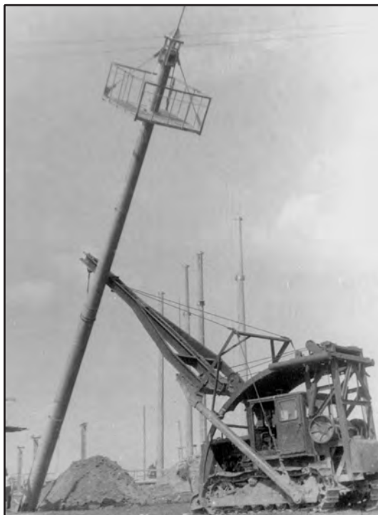
Žaibolaidžio montavimas transformatorinėje pastotėje
