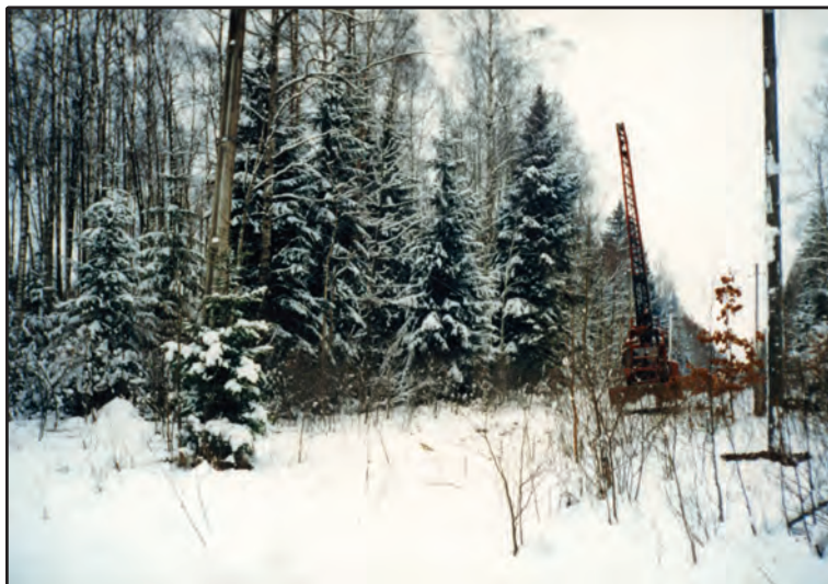
Elektros tiekimo linija tiesiama per mišką
