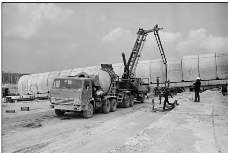
Slėginio vamzdyno montavimo darbai
