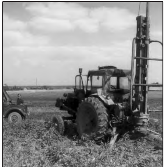
Gręžiamos duobės gelžbetoninėms atramoms
