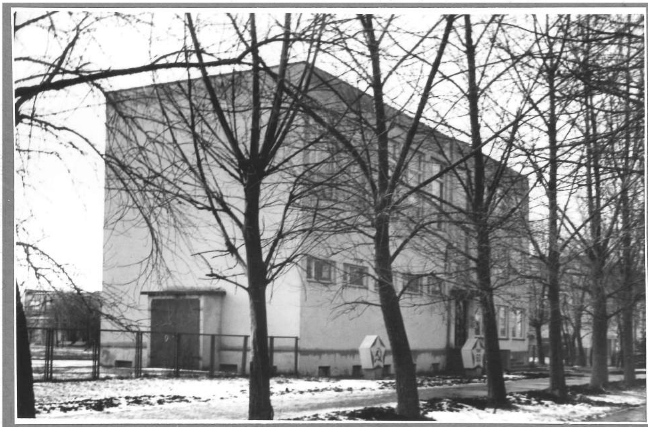
Buvusio PP-5 pastatas po rekonstrukcijos
