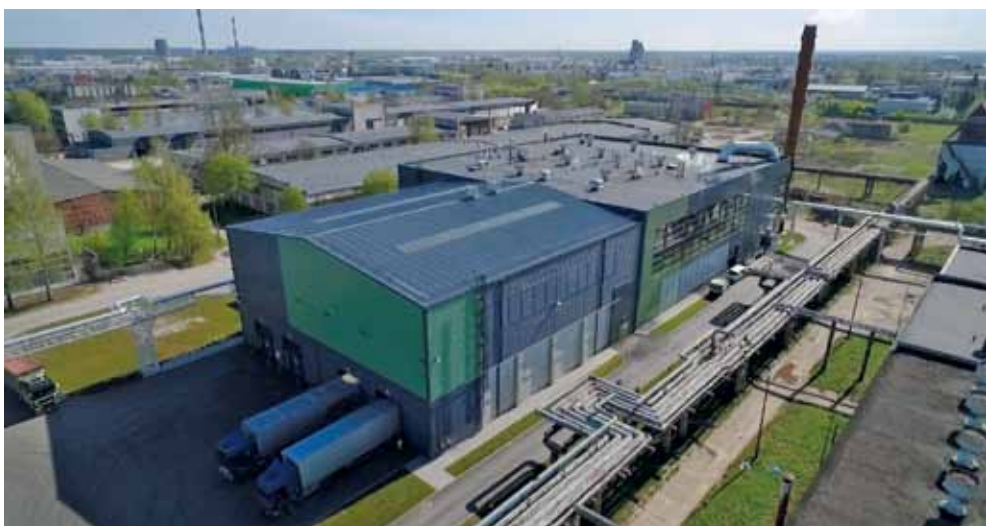
8 pav. UAB „Foksita“. Parametrai: 5MWe (3×12 t/h, 39 bar, 460 °C) katilai ir 6 MW kondensacinis ekonomaizeris. Tipas: kogeneracinė jėgainė su kondensaciniu ekonomaizeriu. Kuras: smulkinta mediena, miško kirtimo atliekos, Vieta: Kaunas, Lietuva. Metai: 2016
