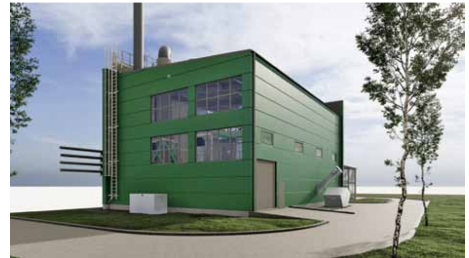
11 pav. Katilinė MPEC Pisz. Parametrai: 5 MW katilas ir 1 MW kondensacinis ekonomizeris. Kuras: smulkinta mediena, miško kirtimo atliekos. Vieta: Pisz, Lenkija. Metai: 2024
