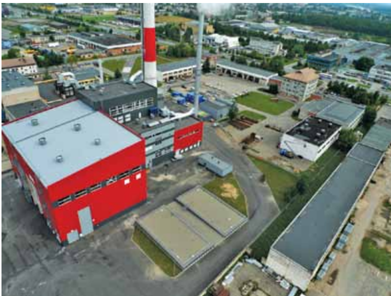
18 pav. Biokuro termofikacinės elektrinės su 40 MW biokuro katilu ir 11 MW turbogeneratoriumi Šiauliuose projektavimas, kurios užsakovas AB „Šiaulių energija“
