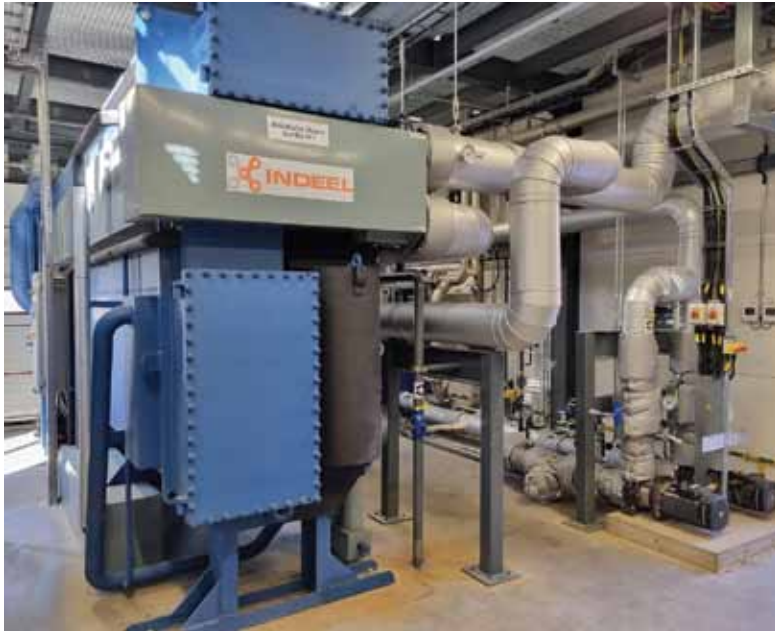
3 pav. Antro laipsnio kondensacinis ekonomizaizeris su absorbciniu šilumos siurbliu
