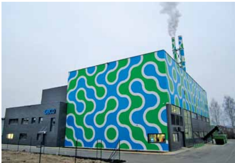
7 pav. UAB „Geco Kaunas“. Parametrai: 16 MW (2×8 MW) katilai ir 4 MW kondensacinis ekonomaizeris. Tipas: vandens šildymo katilinė su kondensaciniu ekonomaizeriu. Kuras: smulkinta mediena, miško kirtimo atliekos, Vieta: Kaunas, Lietuva. Metai: 2012
