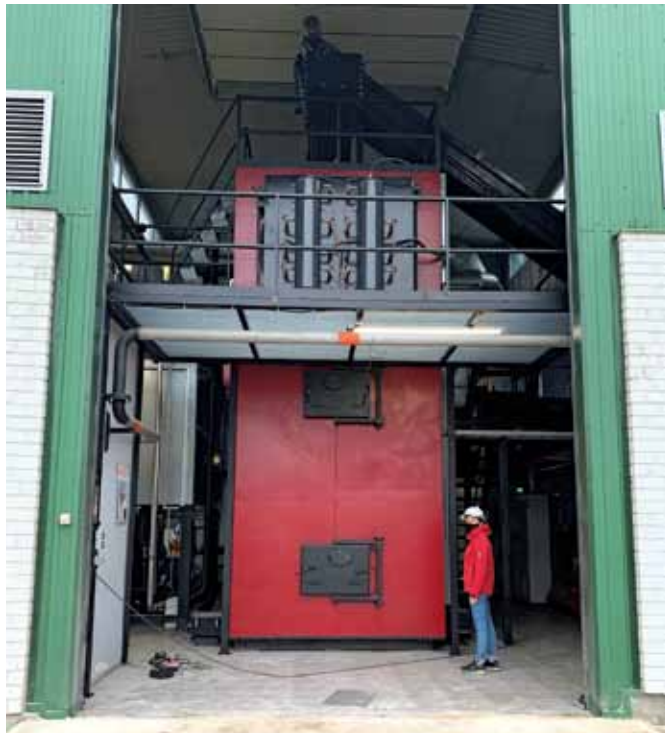
16 pav. Sumontuotas 3500 kW katilas UAB „Gren Švenčionys“ Švenčionių katilinėje
