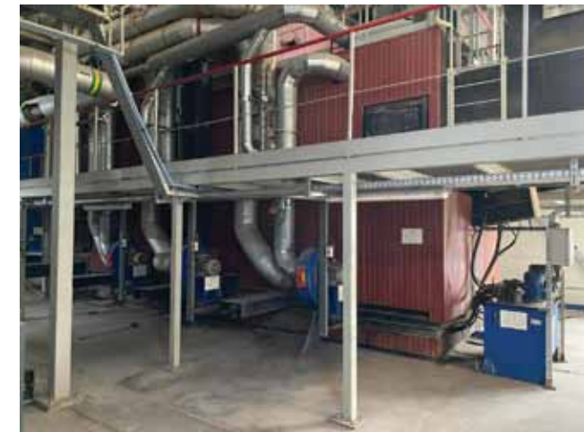
Druskininkų katilinės 10 MW biokuro katilas
