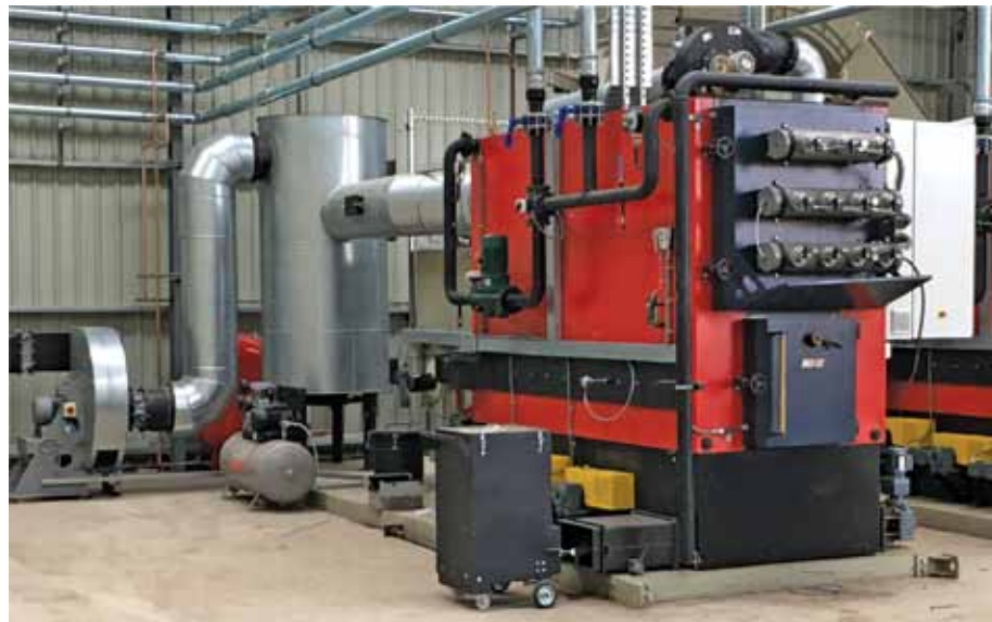
14 pav. UAB „Kalvis“ biokuro katilai
