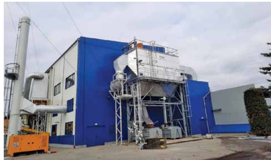
9 pav. Katilinė MPEC Nowy Sącz. Parametrai: 7 MW katilas. Tipas: vandens šildymo katilinė. Kuras: smulkinta mediena, miško kirtimo atliekos, Vieta: Nowy Sącz, Lenkija. Metai: 2020
