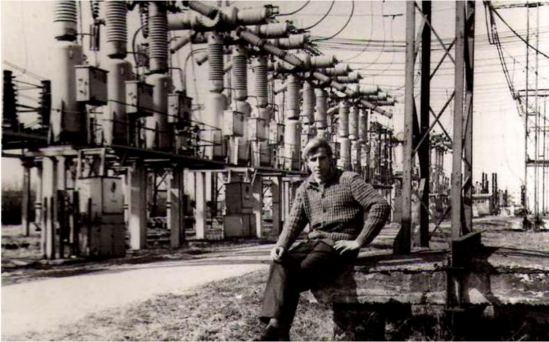
110 kV skirstykla 1979 m.
