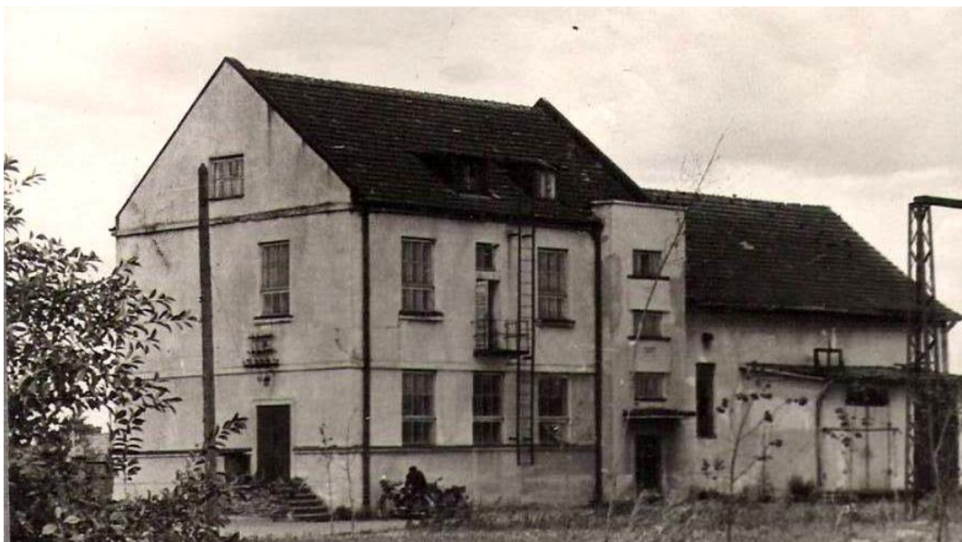
Šiaulių 30/6 kV pastotė ( dešinėje) su priestatu.
