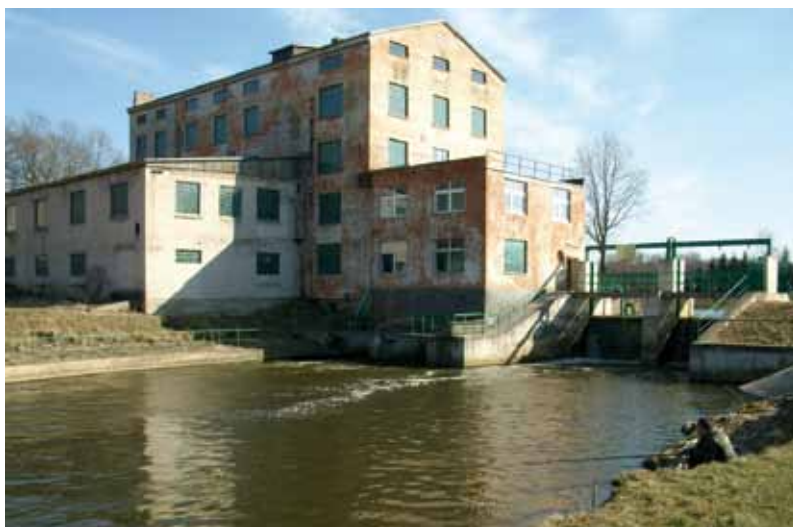
Liudvinavo hidroelektrinė (žemutinis bježas), 2012 m. (Audriaus Bilio nuotrauka)
