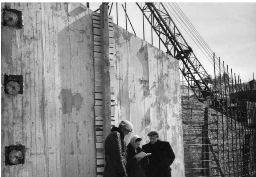
Kauno HE, 1958 m. Iš kairės: Algirdas Brazauskas (Kauno HE direkcijos inžinierius), N. V. Jakovleva (Kauno HE projektavimo organizacijos inžinierė), Stanislovas Danyla (Kauno HE direkcijos inžinierius) tikrina naujų armopanelių montavimą. (Pirmą kartą TSRS panaudojami armopaneliai su darbo armatūra. Gaminama gelžbetonio poligone, belieka tik sumontuoti bloką ir jį užpildyti betonu)
