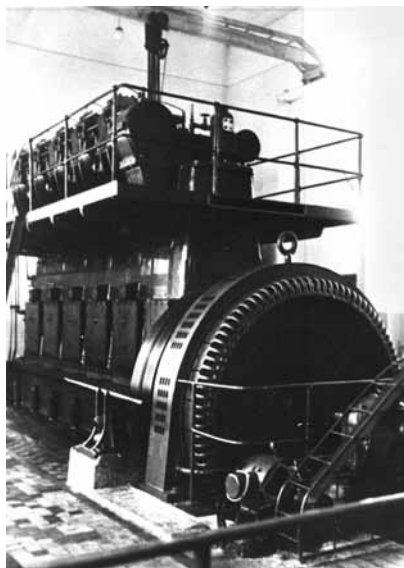
Marijampolės dyzelinės elektrinės 540 kW galios „Fulton“ firmos dyzelis ir elektros generatorius (iš Energetikos muziejaus fondų)
