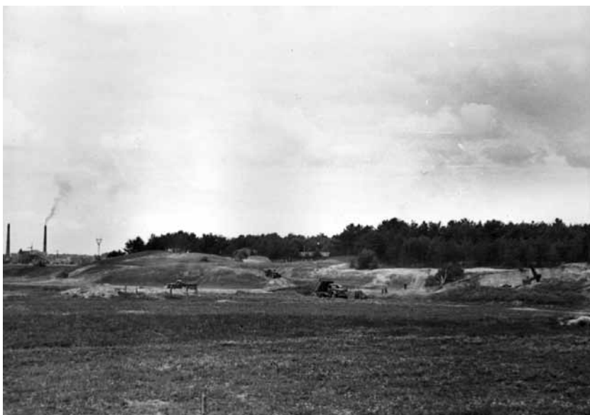
Kauno HE statybos pradžia. Ekskavatorius pradeda kasti gruntą. 1956 m. liepos mėn. 13 d.
