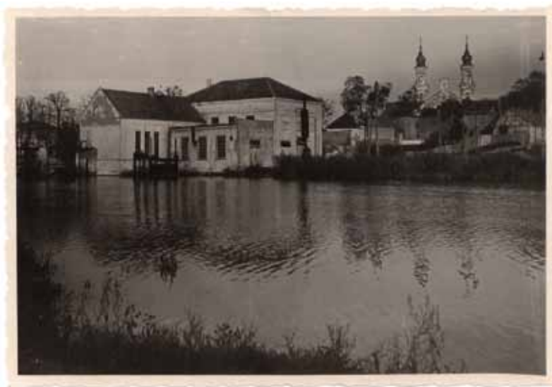
Atstatyta Marijampolės hidroelektrinė ir dyzelinė elektrinė (1955 m. nuotrauka) (Marijampolės kraštotyros muziejaus fondai, Nr. 13579)
