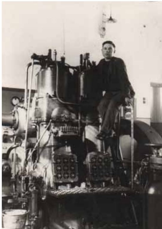
„Polar Atlas“ dviejų cilindrų 150 AG dyzelis. (po karo elektrinės personalo suremontuotas veikė ir su vienu cilindru). 1937 m. nuotrauka
