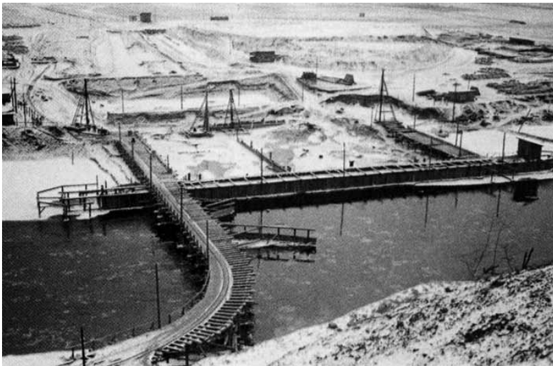
S. Kolupaila. Turniškių hidroelektrinės statyba. 1939 m. gruodis. Statybos tiltas ir siaurasis geležinkelis (Tai Lietuva. Lietuvos spaudos fotografija, 2009)
