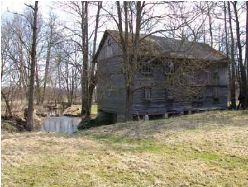
J. Rimšos hidroelektrinės pastatas 2012 m. balandžio 11 d. (Audrius Bilio nuotrauka)
