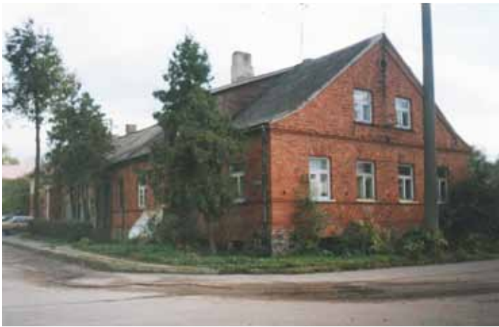
Biržų m. savivaldybės elektrinės pastatas, pastatytas 1935 m. 1967 m. nuotrauka
