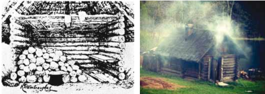
16.1 pav. Pirties krosnis (Maciūkų k., Kretingos aps., statyta 1864 m., piešta 1936 m.), dešinėje – veikianti dūminė pirtis
