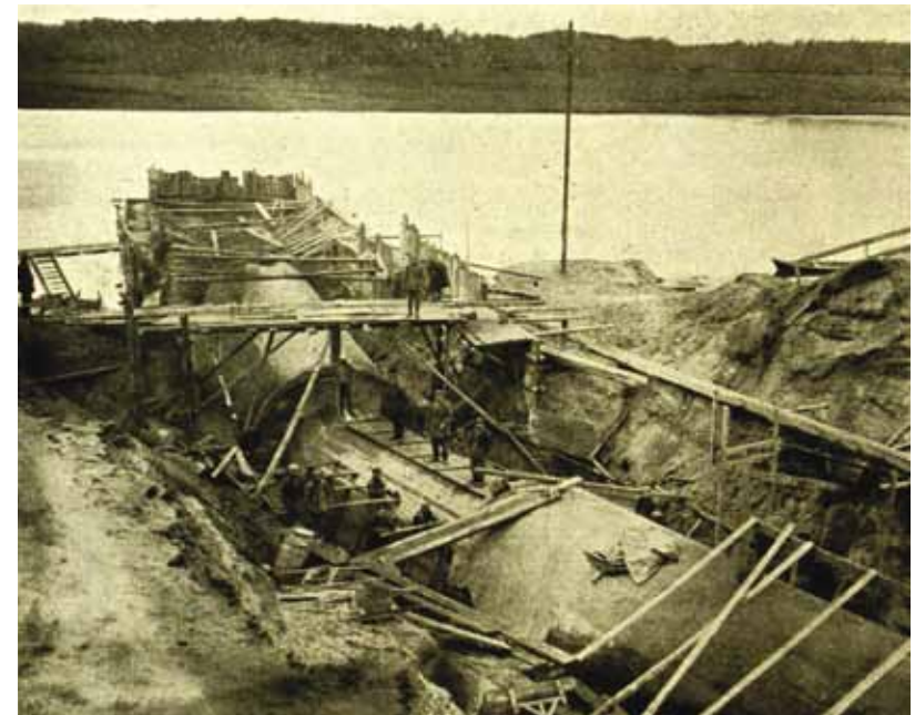
Betonuojamas cirkuliacinio vandens vamzdis (Technika ir ūkis, Nr. 1, 1929 m.)
