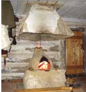
7 pav. Moliu aptepto vytelių kamino rekonstrukcija
