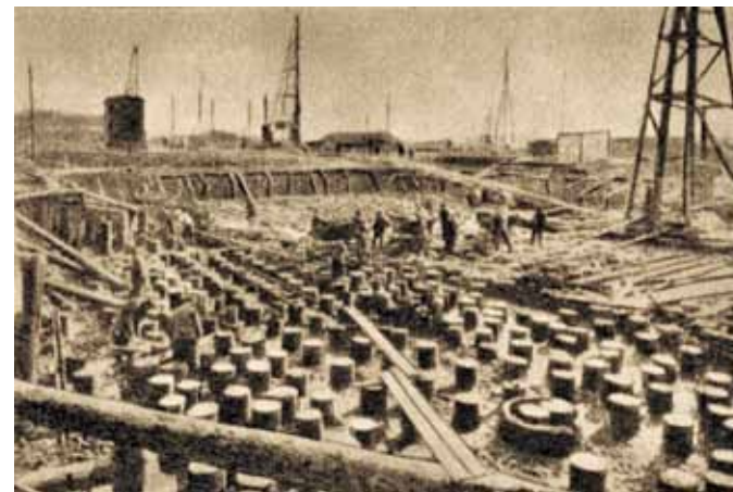
Sukalti poliai Klaipėdos šiluminės elektrinės statybos aikštelėje, 1928 m. (iš Energetikos ir technikos muziejaus fondo)
