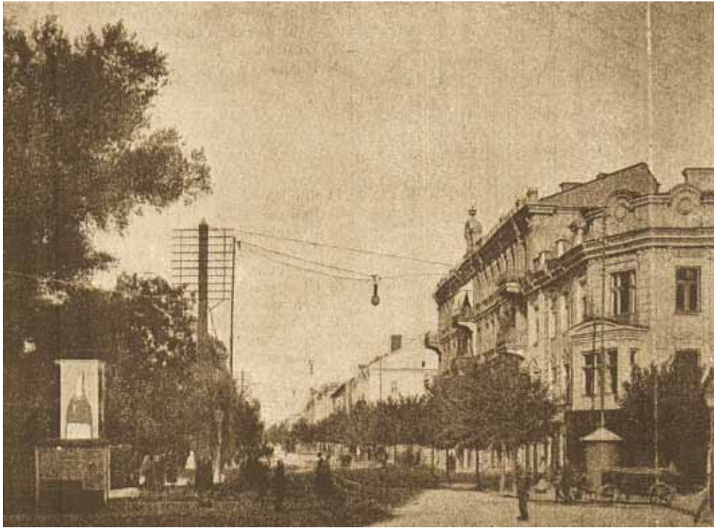
Lankinės elektros lempos ant išstemptų lynų Vilniuje, (Jurgio) Gedimino prospekte 1906 m. (V. Malinovski. Opisanie Vilenskoj gorodskoj centralnoj električeskoj stancii. Vilna, 1906)
