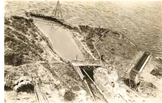
Rėkyvos elektrinės cirkuliacinio vandens kanalo statyba, 1939-07-04 d.) (Iš Lietuvos aviacijos muziejaus fondų, GEK-806)
