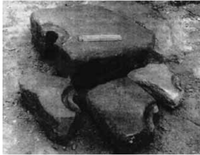
9 pav. Grindų plokštės su angomis pašildytam orui
