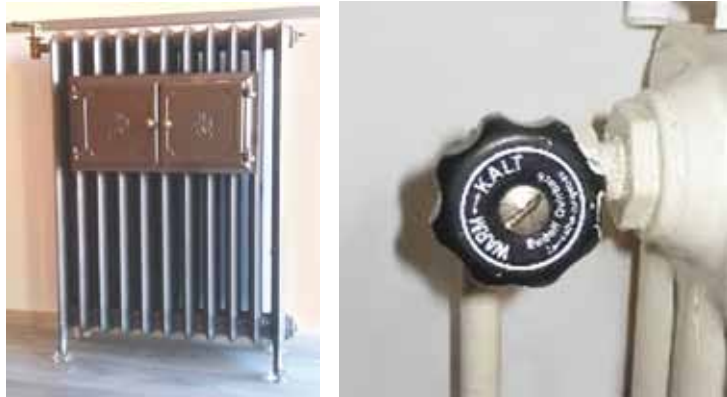
32 pav. Kauno tarpukario statybos šeimyniniuose namuose sutinkamas radiatorius su kamera šiltam maistui (kairėje), šilumos atidavimo reguliavimas – ne XXI a. naujiena (dešinėje)
