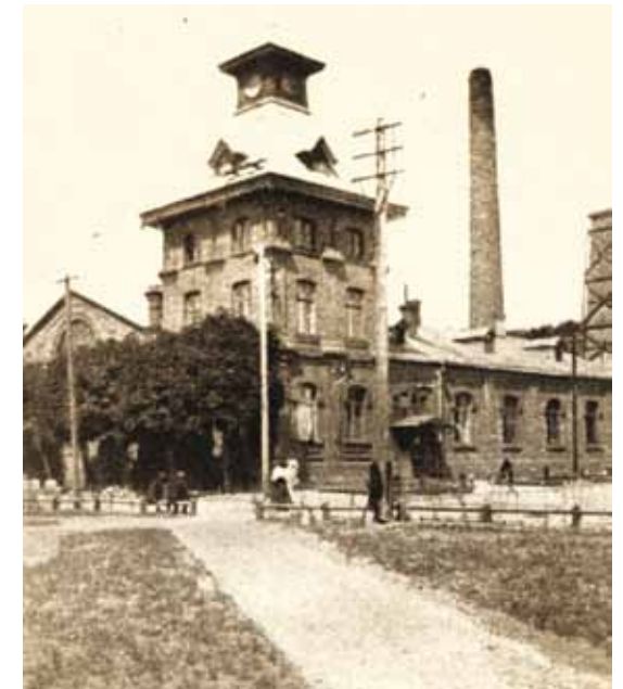
Belgo R. F. Šmatcerio 1900 m. pastatyta Kauno elektrinė (iš Energetikos ir technikos muziejaus fondų)
