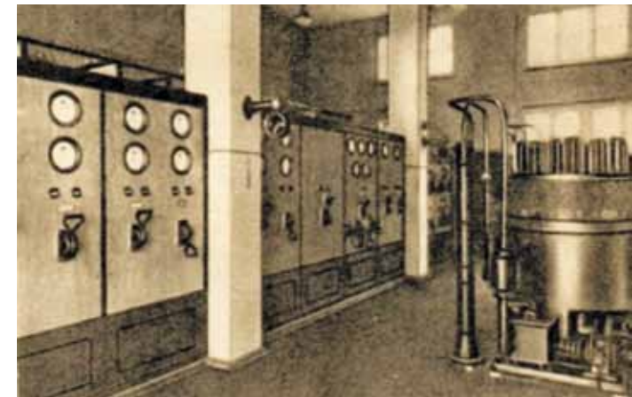
Klaipėdos miesto elektros lygintuvė, kurioje iš celiuliozės fabriko elektrinės gaunama kintamoji srovė buvo keičiama į nuolatinę, 1927 m. (iš Energetikos ir technikos muziejaus fondo)
