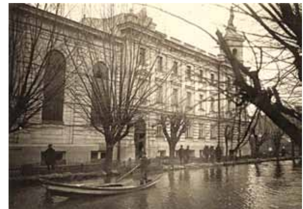
Apsemta centrinė elektrinė, 1931-04-25
