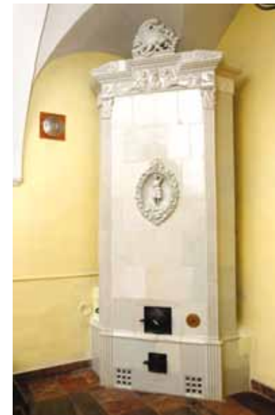
18 pav. Krosnys. 1 – viryklė su ketaus žiedais, parenkamais pagal puodo dugną (rinkėmis) ir šildymo sienoje, tokios viryklės pradėtos statyti XX a. pradžioje, 2 – Mažosios Lietuvos kombinuota krosnis, 3 – restauruota XIX a. pabaigos krosnis Vilniaus universiteto bibliotekos prieigose, 4 – eilinė XX a. šildymo krosnis
