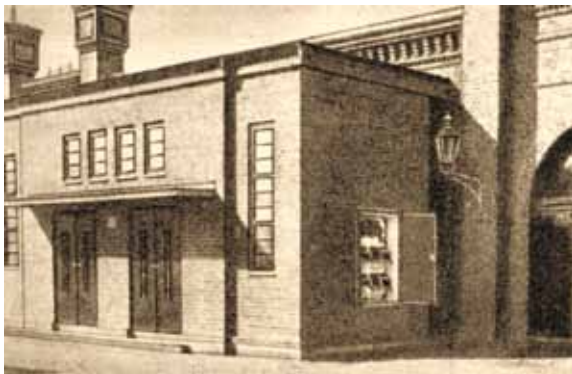
6/0,4 kV transformatorinė pastotė, 1929 m. (Energetikos ir technikos muziejaus fondo)
