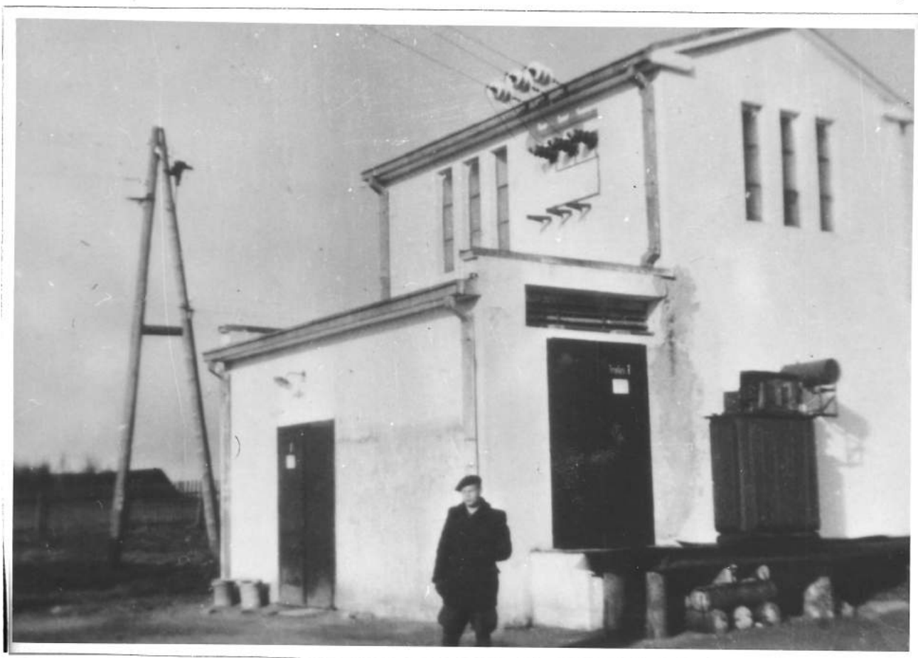
30/6 kV transformatorinė pastotė Radviliškyje.
