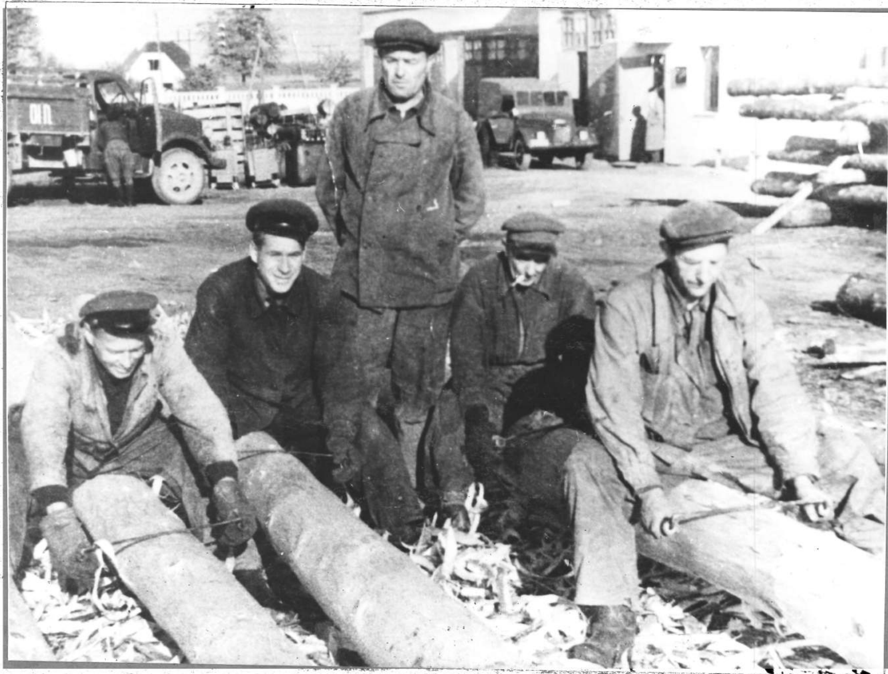
1957 m. Atramų nužievinimas atliekamas rankiniu būdu. Nuotraukoje el.mont. A.DOMARKAS, el. mont. A. KOSTKUS, vyr. el. mont. K. ŽINDULIS, el. mont. P. JUŠKEVIČIUS ir el.mont. B. PETRULIS darbo metu.
