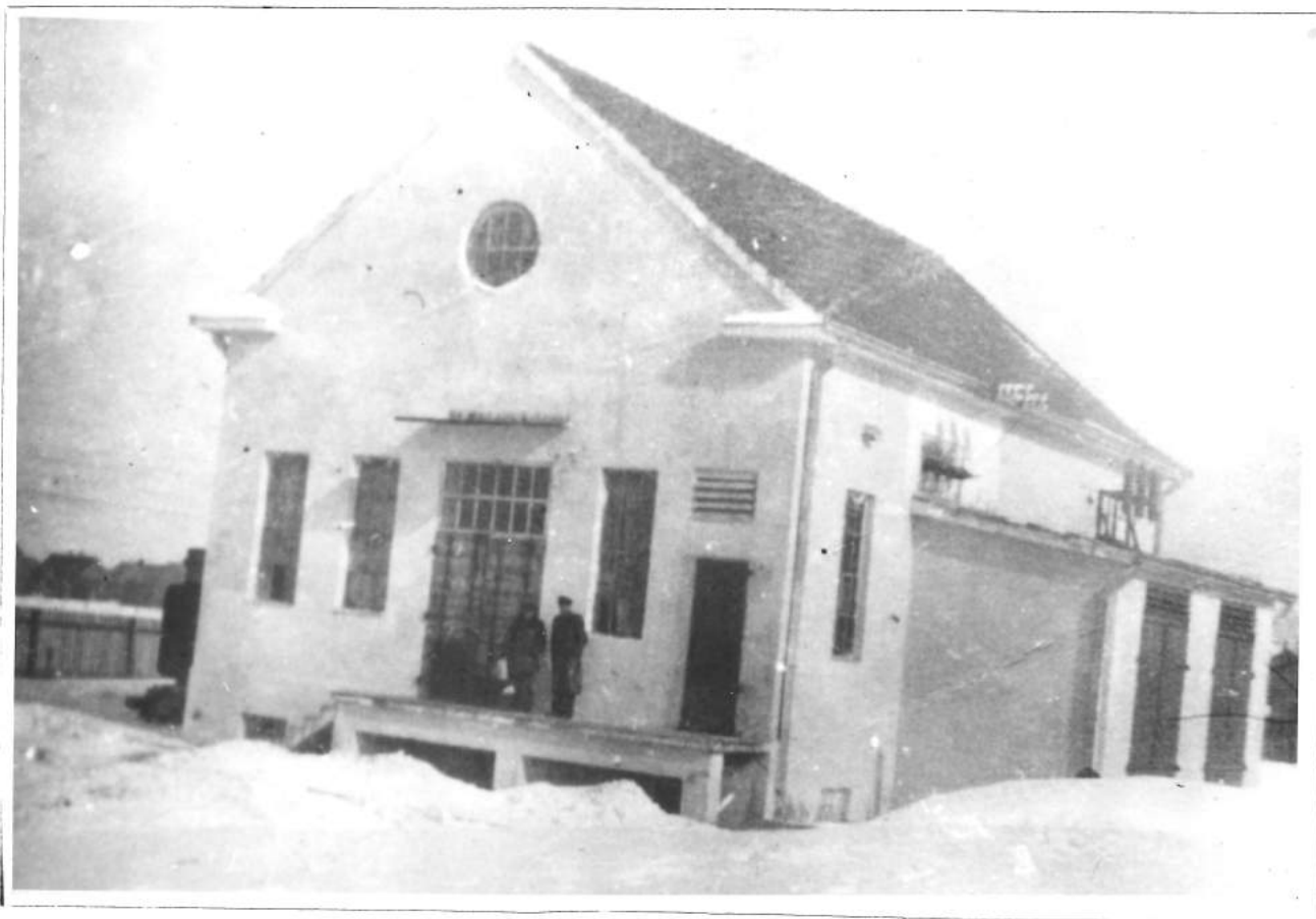
30/6 kV transformatorinė pastotė Šiauliuose.
