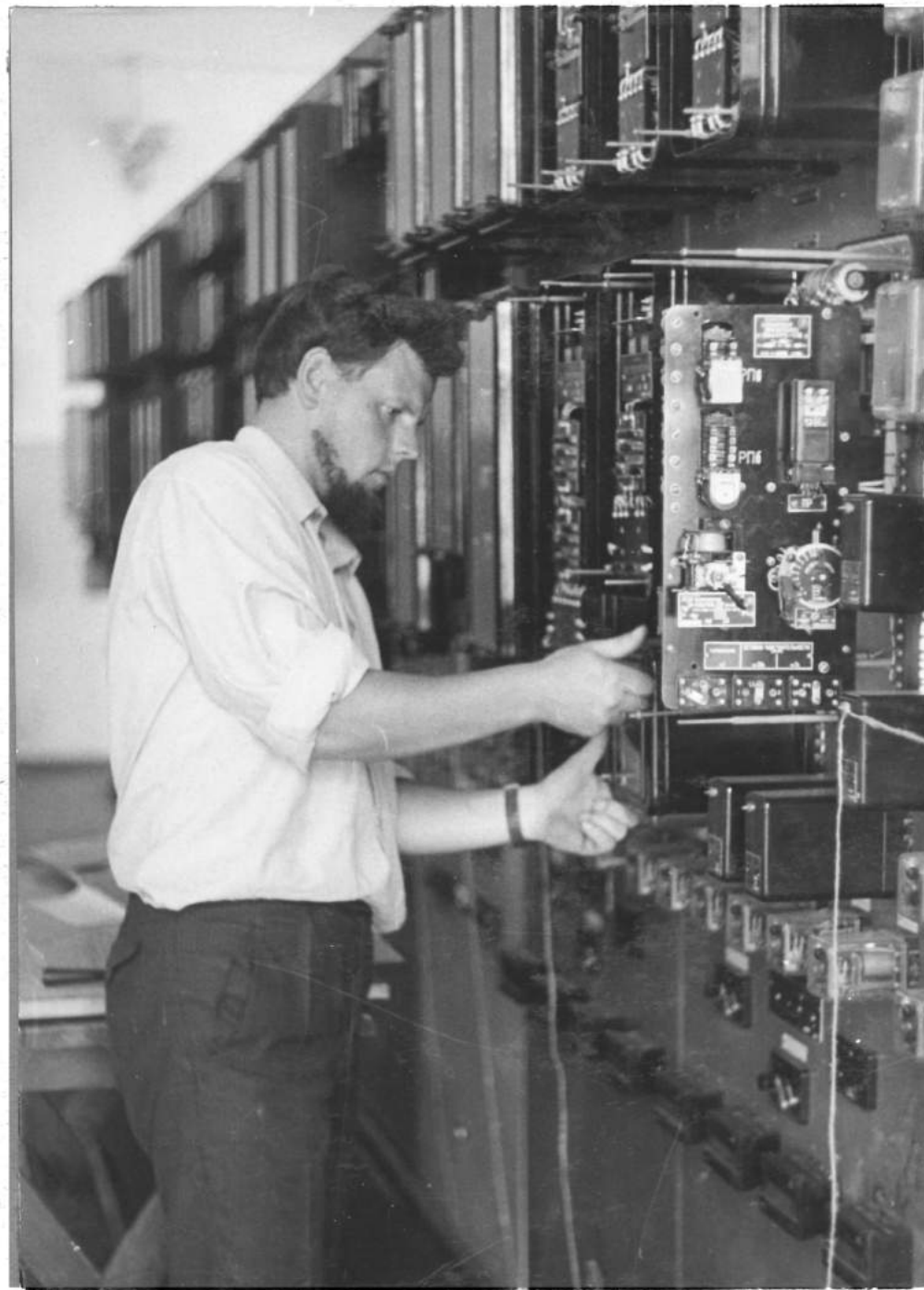
RAAM tarnybos meistras J. Vernys atlieka relinės apsaugos derinimo darbus Kuršėnų 110/35/10 kV pastotėje.
