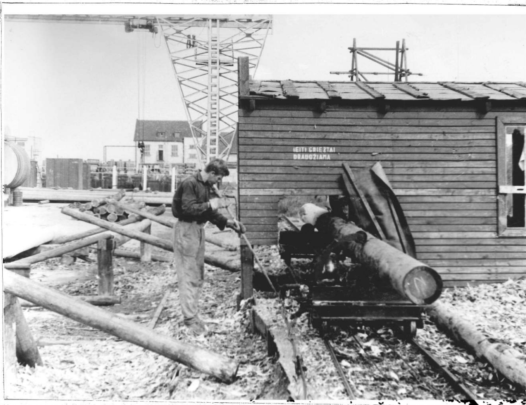
1965 m. sunkus medinių atramų nužievinimas buvo mechanizuotas.
