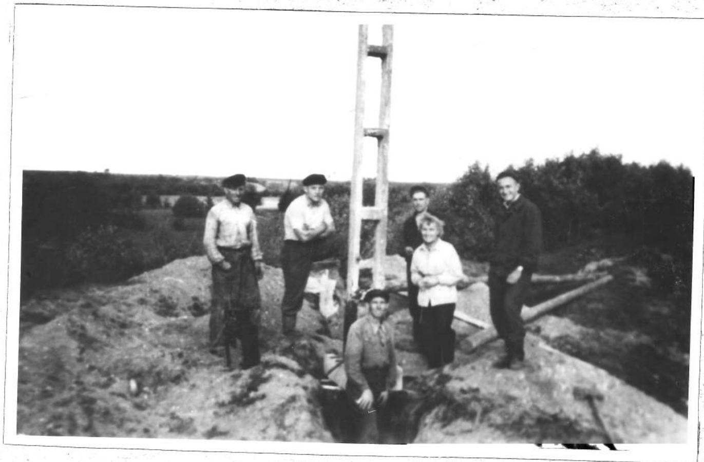
Pirmosios 10 kV linijos gelžbetoninėmis atramomis statyba Vieškniuose 1959 m.
