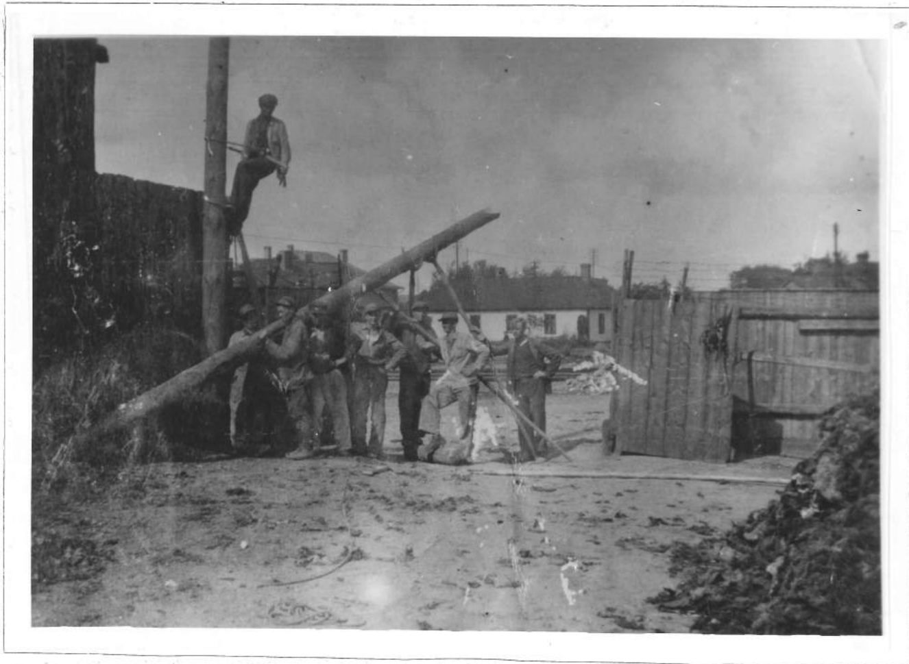
1943 metai. Sunkūs duobių kasimo ir atramų statymo darbai buvo atliekami rankiniu būdu.
