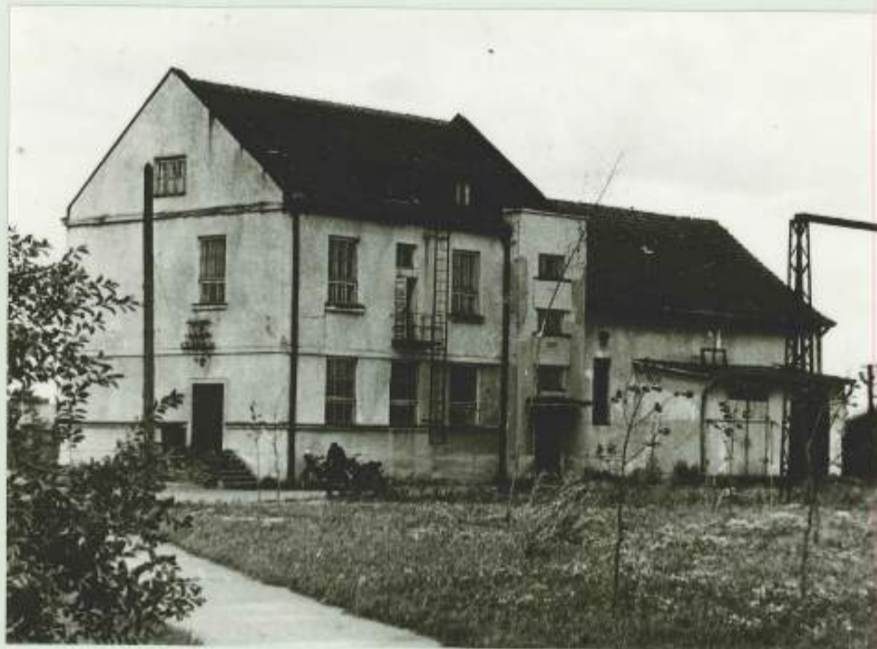
30/6 kV pastotės uždaros skirstyklos pastatas su 2-jų aukštų priestatu
