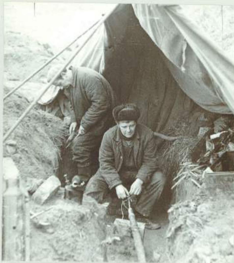
Kabelių remonto brigada: V.Platmalniekas ir J.Pocius
