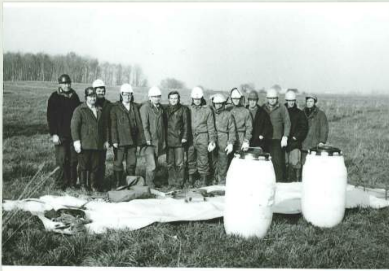
Linijų tarnybos brigada su darbo įranga 1986 11 13
