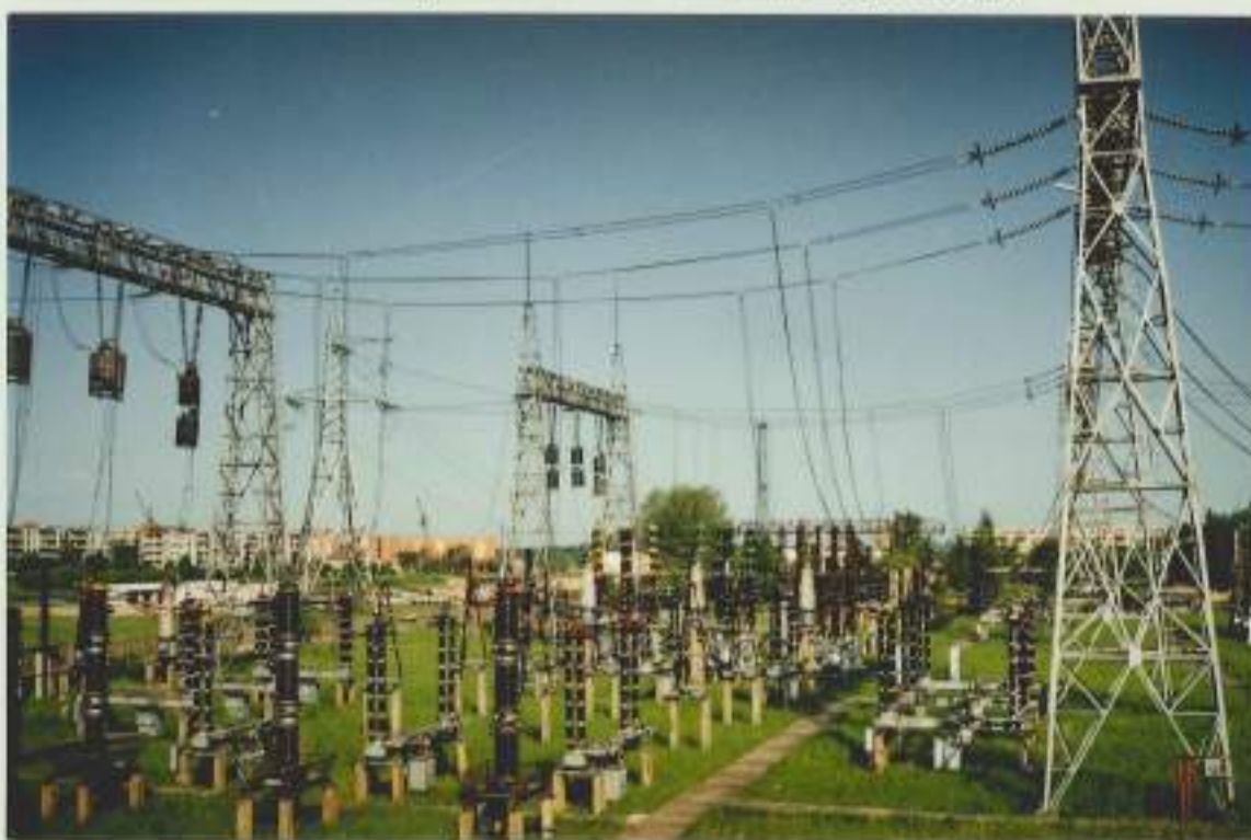
330 kV skirstyklos tranzitinė dalis prieš rekonstrukciją ir po rekonstrukcijos
