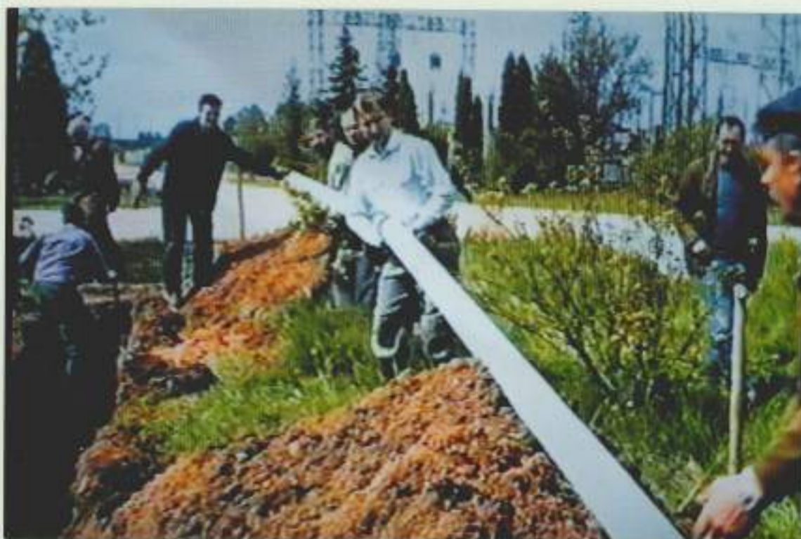
Ryšių kabelių kanalizacijos rekonstrukcija
