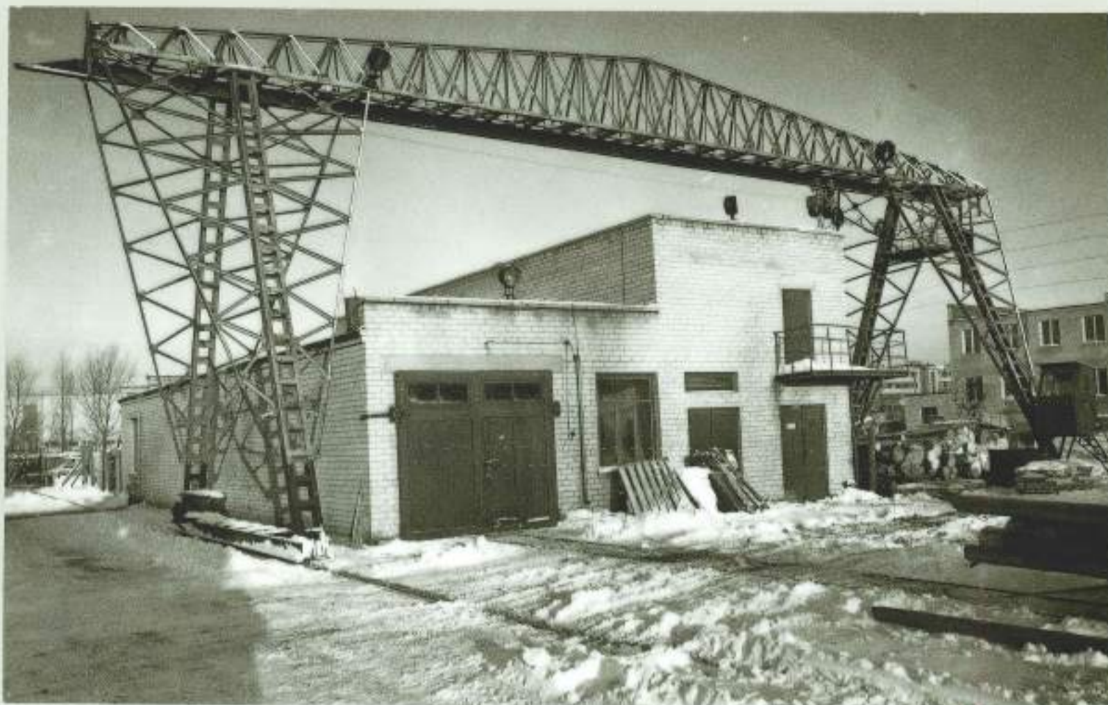
Naujos technikos mechaninės dirbtuvės
